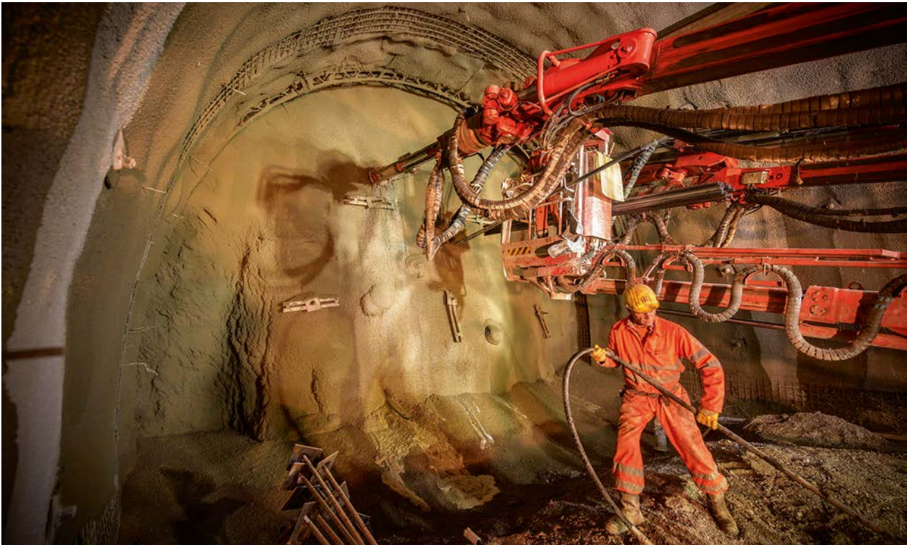
Abbildung 14: Tunnelvortrieb beim Semmeringbasistunnel Bild: ÖBB/Andreas Ebner
