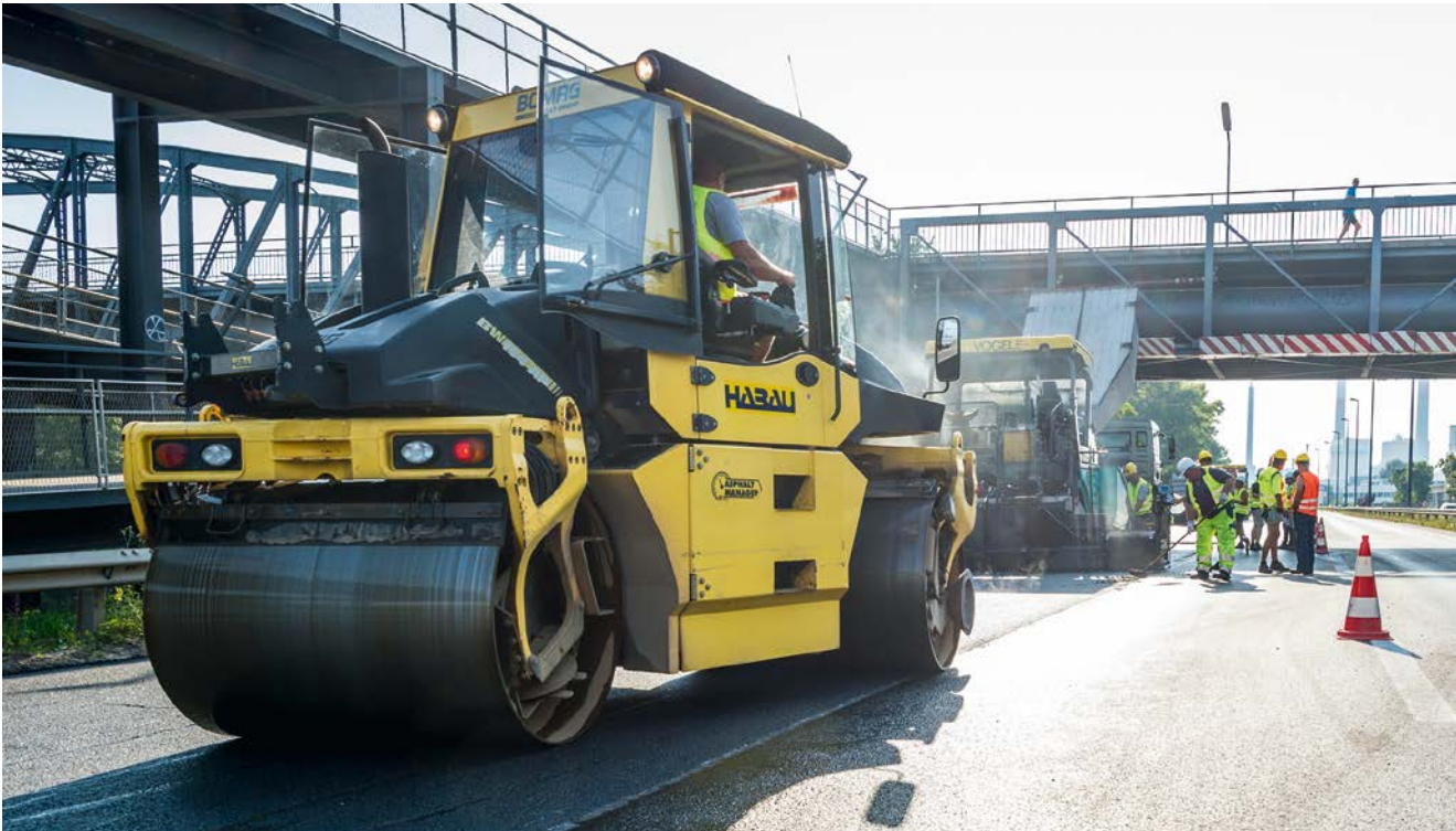
Abbildung 17: Instandhaltungsarbeiten auf der Autobahn Bild: ASFINAG
