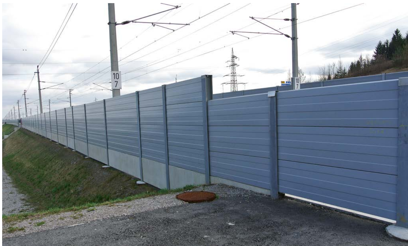
Abbildung 10: Lärmschutzwände entlang der Gleise der ÖBB-Infrastruktur Bild: ÖBB/Kletz
