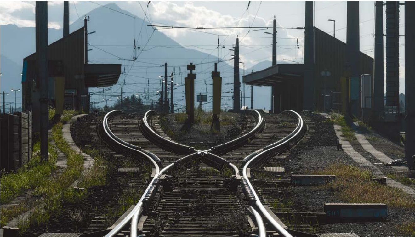
Abbildung 12: Blick auf Gleise der ÖBB-Infrastruktur, Bild: ÖBB/David Payr
