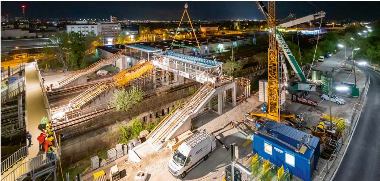
Abbildung 16: Bauarbeiten an einem Übergangssteg über Gleise in Wien, Bild: ÖBB/Michael Fritscher
