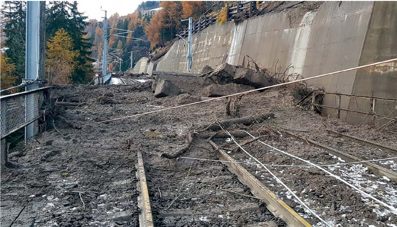
Abbildung 8: Schäden an der Schienen- infrastruktur nach einem Unwetter, Bild: ÖBB/Heinz Gatterer
