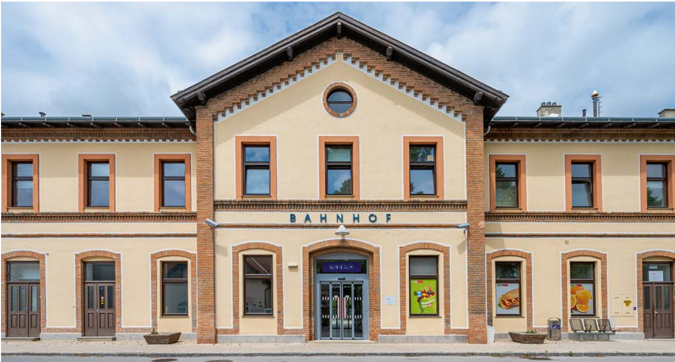
Abbildung 15: Bahnhofsgebäude Mistelbach Bild: ÖBB/Michael Fritscher
