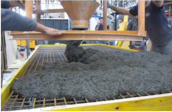
Abbildung E. 6: Einbringen des Betons
