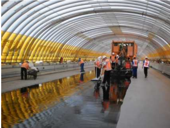
Abbildung 3.22: links: Aufbringen der Epoxy Deckschicht nach dem Betonieren; rechts: fertige Fahrbahn [20]
