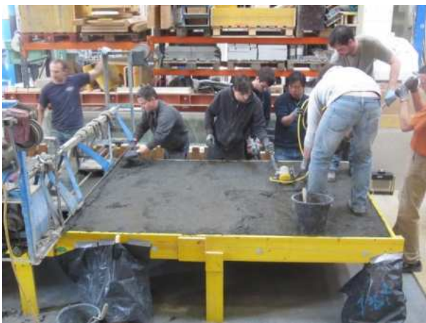
Abbildung E. 7: Verdichten und Abziehen des Betons
