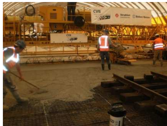
Abbildung 3.21: links: Einstreuen des Granulats vor Betonieren; rechts: Betonieren mit Gleitschalungsfertiger [20]
