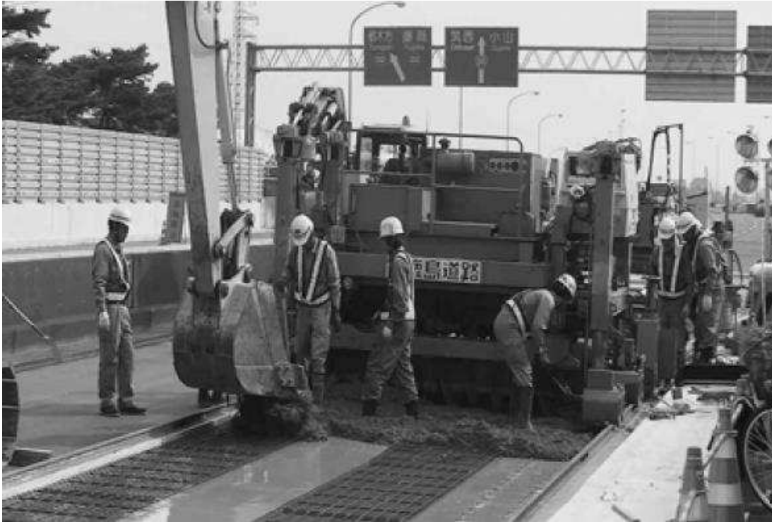
Abbildung 3.26: Arbeiten am Ohira Viadukt [25]
