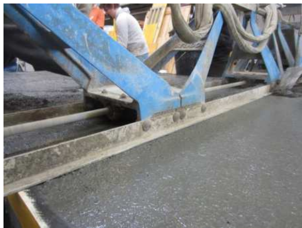
Abbildung E. 7: Verdichten und Abziehen des Betons
