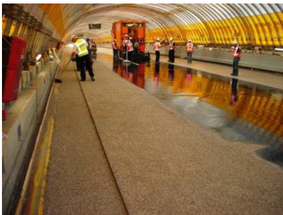
Abbildung 3.21: links: Einstreuen des Granulats vor Betonieren; rechts: Betonieren mit Gleitschalungsfertiger [20]
