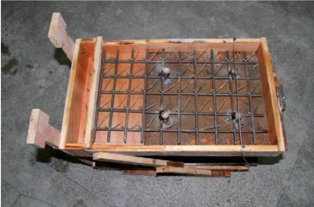
Abbildung 3.17: Versuchskörper vor dem Betonieren [19]
