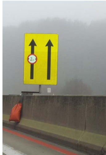
Abbildung 58: Derzeitige Befestigung an einer Betonleitwand
