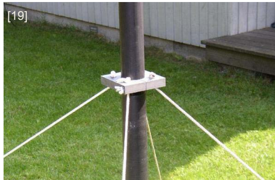
Abbildung 54: mögliche Abspannvorrichtung am Mast
