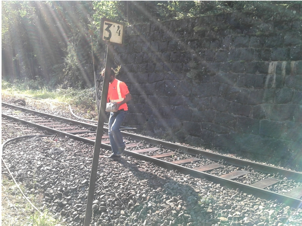
Abbildung 28: ÖBB Streckenabschnitt Hieflau-Eisenerz, km 3.450, Jägerkogel im Gesäuse, eines der möglichen Testgebiete. Gefährdung hauptsächlich durch Steinschlag/Felssturz Prozesse.
