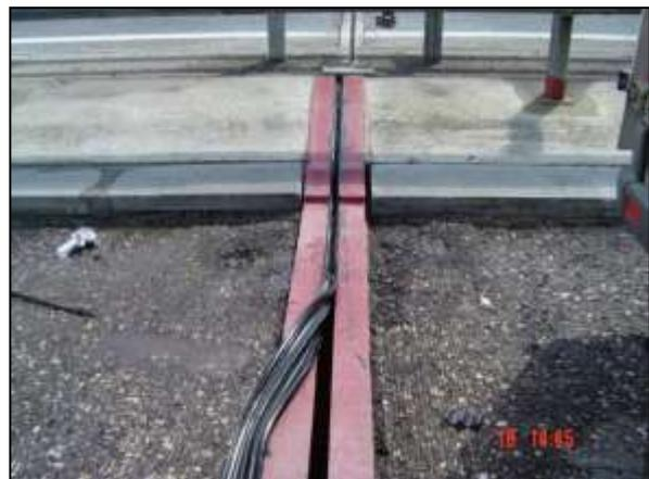
Abbildung 41: **Einknüpfen des Dichtprofils**
