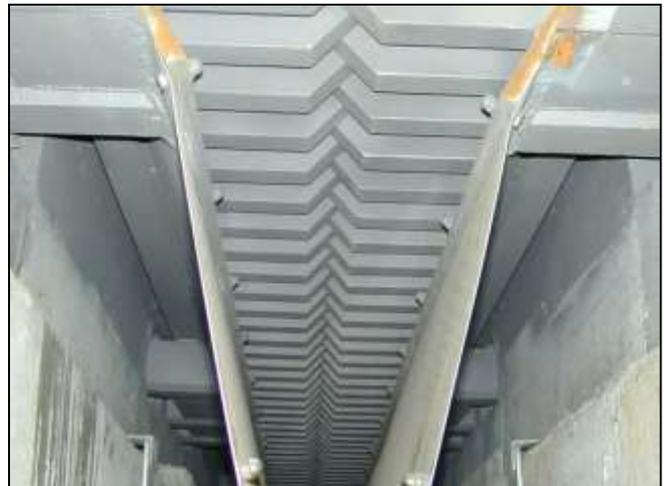
Abbildung 34 – **Untersicht des fertig eingebauten Finger Typ F**
