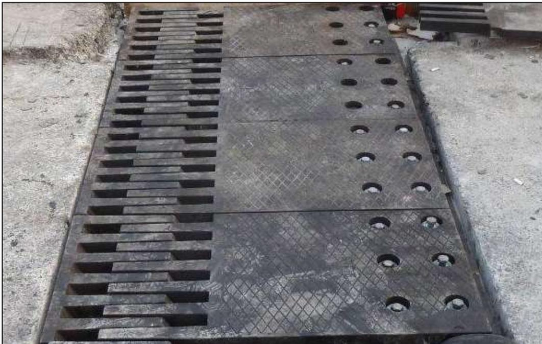
Abbildung 57: TENSA-FLEX RC
