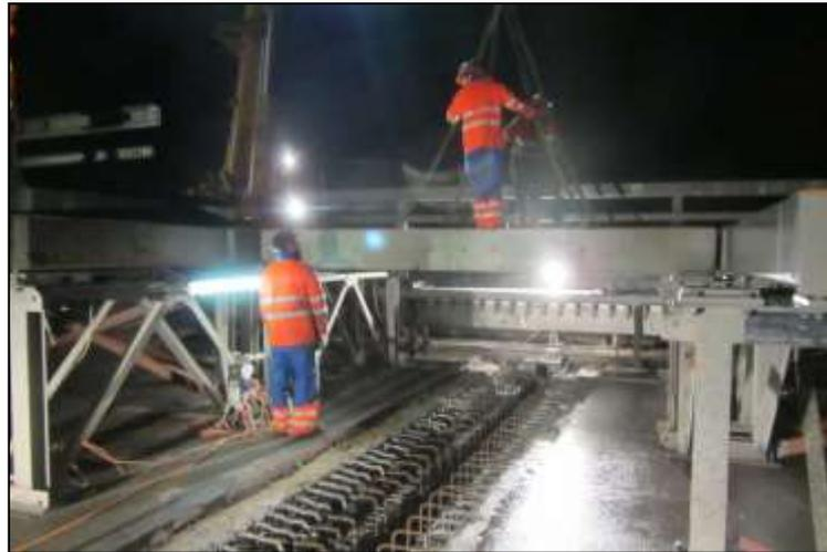
Abbildung 55: Öffnen eines Fly-Over Mittelteils zum Einheben der neuen Fahrbahnübergangskonstruktion (Einbau der neuen FÜK am Zeinigerviadukt)
