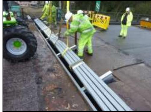
Abbildung 26: **Einfädeln der neuen FÜK**
