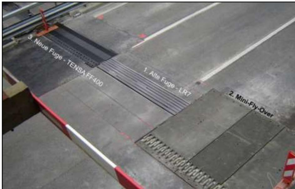
Abbildung 2: **Ablauf: 1. Ausbau bestehende FÜK, 2. Überbrücken mittels Mini-Fly-Over 3. Einbau neue FÜK**
