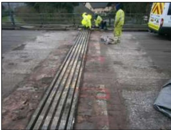
Abbildung 21: **Asphalt entfernen**
