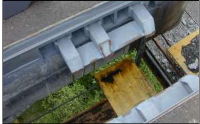
Abbildung 32 – **Heraustrennen der alten Lamellen und Traversen**
