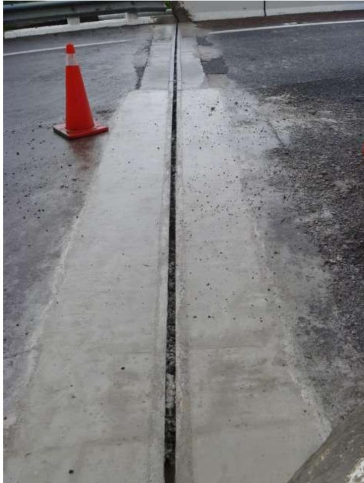
Abbildung 67: **Abschnittweiser Einbau häufig dann nicht zu umgehen, wenn die Fugen besonders lang sind oder Sperrzeiten nicht einzurichten**
