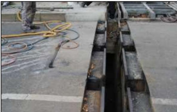
Abbildung 16: **Freilegen der Traversenkästen und Entfernen aller beweglichen und zu ersetzenden Bauteile**
