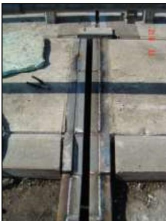
Abbildung 40: **Anschweißen des neuen Randprofils**
