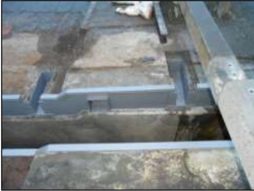
Abbildung 25: **Aufbringen Korrosionsschutz**
