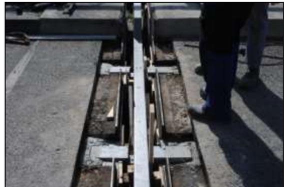
Abbildung 17: **Einsetzen der neuen FÜK**
