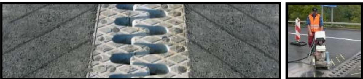
Abbildung 63: Kragfingerfuge mit beidseitigem Einsatz von Stützrippen
