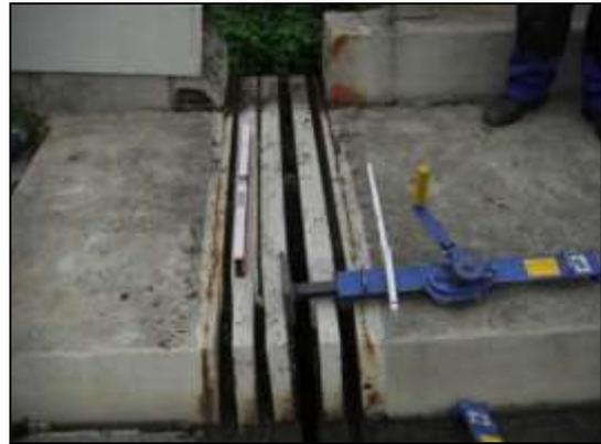
Abbildung 15: **Zusammenpressen der Lamellen für den Ausbau**
