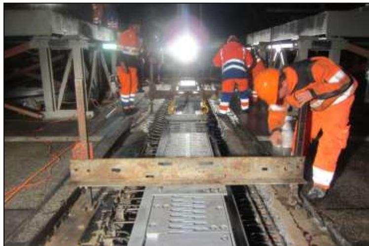
Abbildung 56: Fertig eingehobene Fuge wird fixiert. Der Fly-Over wird anschliessend wieder "geschlossen"
