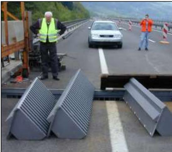
Abbildung 33 – **Lieferung der vorgefertigten Fingerelemente**
