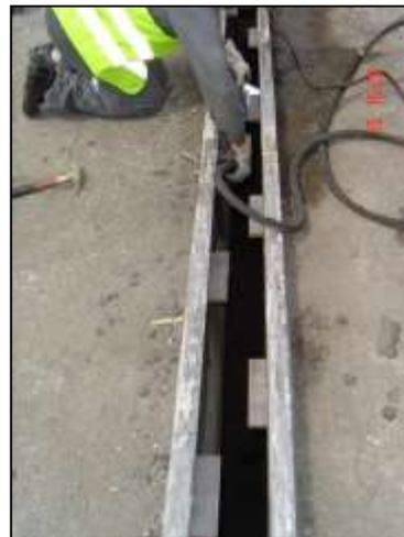
Abbildung 39: **Anschweißen von Installationshilfen**
