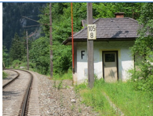
Foto 18. Bestehende Bahninfrastruktur. Oberbau, Masten, Fernsprechanlage.
