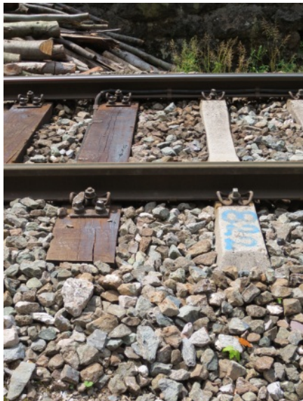
Foto 16. Verschiedene Schwellen entlang einer Strecke
