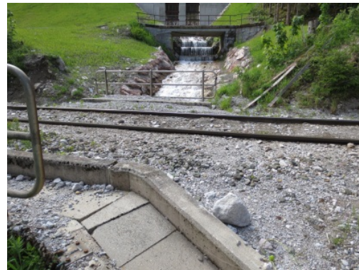
Foto 17. Durchlass unter der Bahnstrecke (Brücke)
