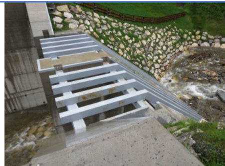
Foto 20. Schrägrechen mit seitlichen Stahlbetonscheiben
