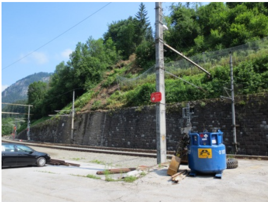
Foto 13. Gleisstrecke mit Stützmauer und steiler Konglomeratbank
