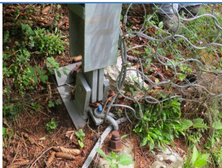
Foto 21. Fundament eines Stehers für ein Steinschlagnetz
