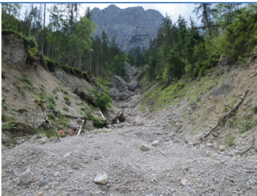
Foto 15. Transfergebiet: Schuttablagerungen im Planspitzgraben
