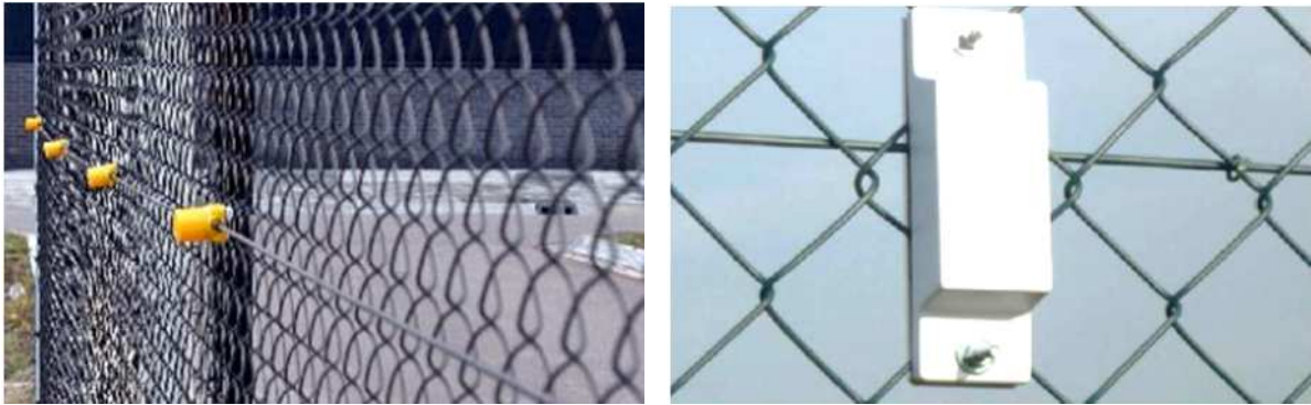
Abbildung 32: Erschütterungstags zur Impactdetektion an Schutzzäunen
