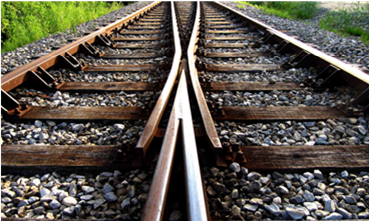
ABB 2. Bahnschwellen aus Holz, imprägniert mit Kreosot (Foto: Rainer Sturm)
