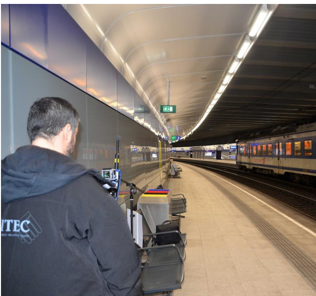
ABB 1. Messungen am Bahnsteig
