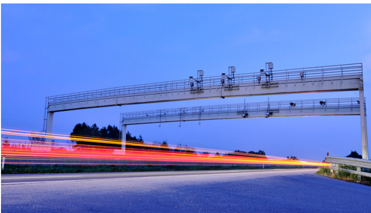
Abbildung 1: VoRAB setzt Verkehrsdaten aus strecken- und querschnittsbezogenen Erfassungssystemen zur Generierung von Reisezeitprognosen ein (Foto: ASFINAG)
