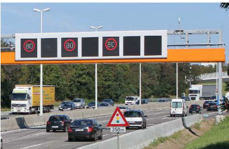
ABB 1. Streckenbeeinflussungsanlage 2.710 mit Photovoltaischer Versorgung, PV SBA 2.710 (Quelle: ASFINAG)
