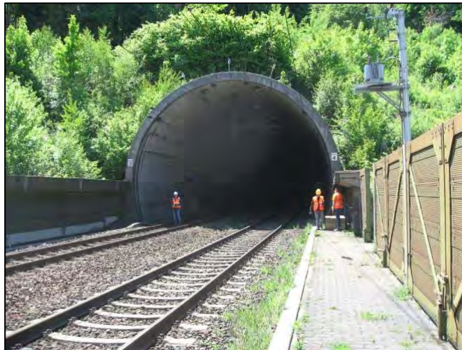
Abbildung 94 Nordportal des Inntaltunnels (Bild: Sindesberger)
