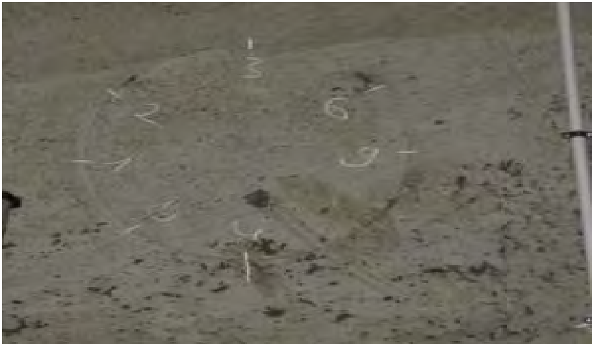
Abbildung 87: Anzeichnen der Bohrungen auf der Betonoberfläche
