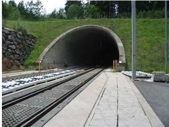
Abbildung 97; Tunnel Hengsberg Nordportal
