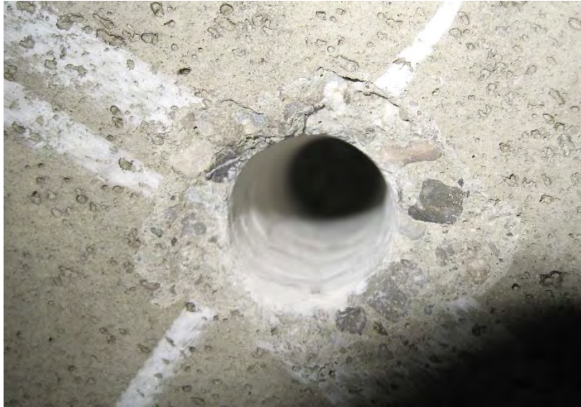
Abbildung 88: Gereinigtes Bohrloch
