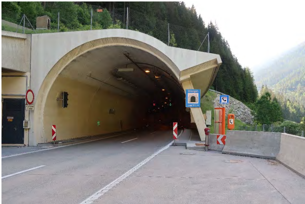
Abbildung 99; Tunnel Strengen Westportal, Südröhre
