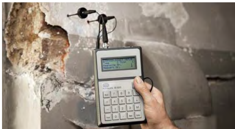
Abbildung 8: Elektrische Widerstandsmessung mit einem Gerät der Firma GANN; geeignete Elektrodenpaare sind von 2,5 bis 30 cm Länge erhältlich [33]
