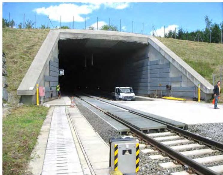
Abbildung 98: Tunnel Hengsberg Südportal
