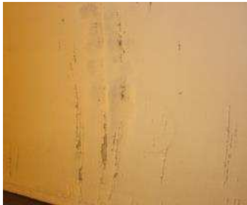
a) Streifenförmige Abblätterungen
