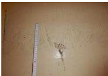
a) Schwache Haftung ab 2 m Höhe
