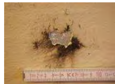
c) Schwarze Stelle mit pulvriger Spachtelmasse
