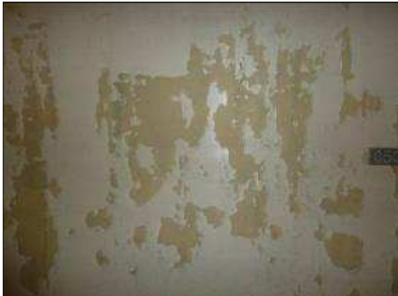
Flächige Ablösungen der Tunnelbeschichtung
