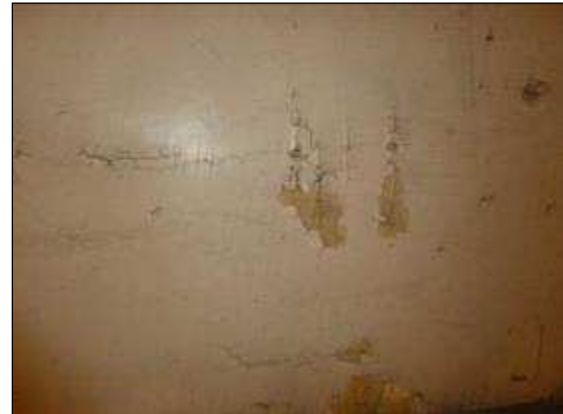
Risse und Ablösungen der Tunnelbeschichtung
