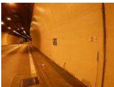
a) Schadfremie Tunnelbeschichtung
