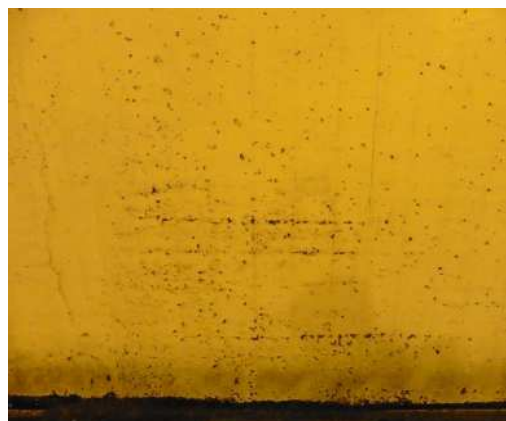
a) Abplatzungen durch Unterwanderung
