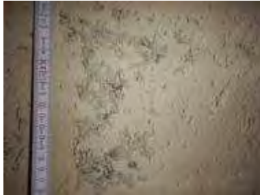
a) Oberflächenverschmutzung mit feiner Abplatzung
