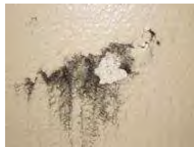
b) Schwarze Stelle mit pulvriger Spachtelmasse
