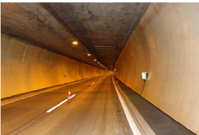
ABB 1. Katschbergtunnel Fahrtrichtung Salzburg bei der Begehung am 3.6.2015
