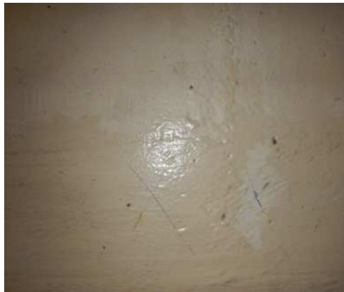
a) Helle Stellen mit weicher Spachtelung im Wolfsbergtunnel – RFB Salzburg
