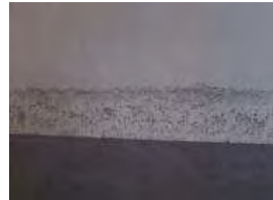
c) Schäden im unteren Bereich
