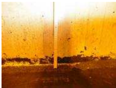
a) Durchgängige Schädigung an der Unterkante
