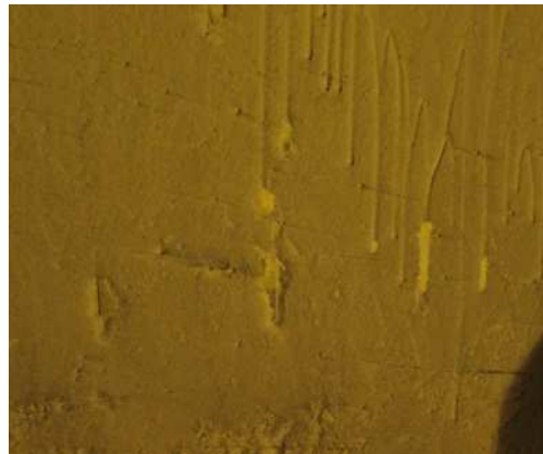
Abbildung 59: Läuferbildung im Ganzsteintunnel
