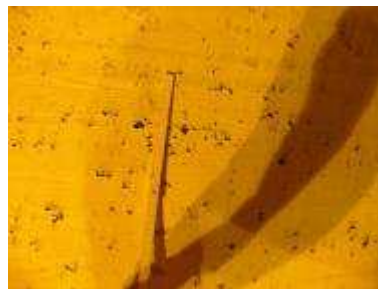
b) Immer wieder auftretende Abplatzungen
