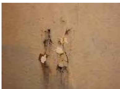
a) Schwarze Oberfläche mit pulvriger Spachtelung
