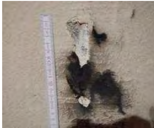
a) Schwarze Verfärbung im Wolfsbergtunnel – RFB Villach
