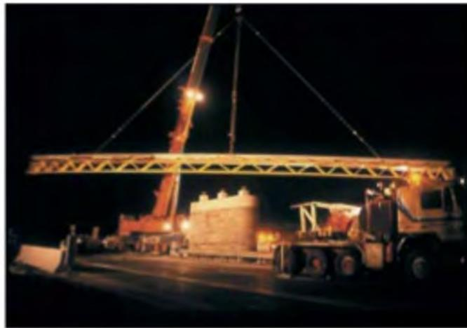
**Abbildung 2.50: Einbau Brückentrio Sattledt [10]**
