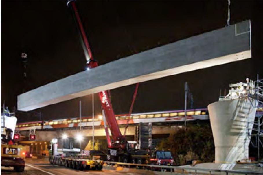
**Abbildung 2.46: Einheben eines vorfabrizierten Brückenträgers [15]**
