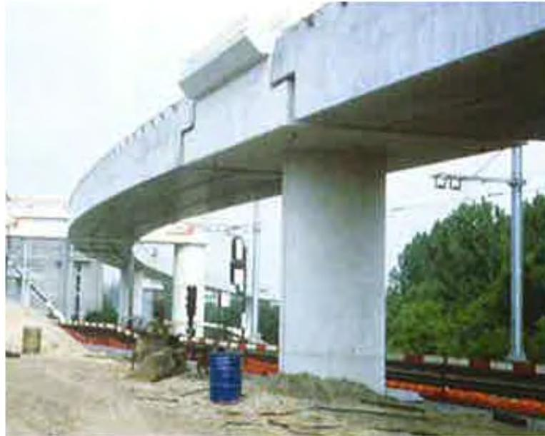
Abbildung 2.34: U-Bahn-Viadukt mit gekrümmten Kastenträgern [10]
