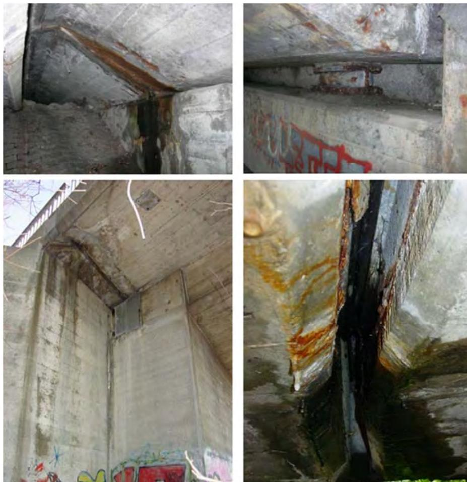
**Abbildung 2.5: Beispiele für durchnässte Widerlager infolge undichter Fahrbahnübergänge und die dadurch verursachten Folgeschäden [6]**
