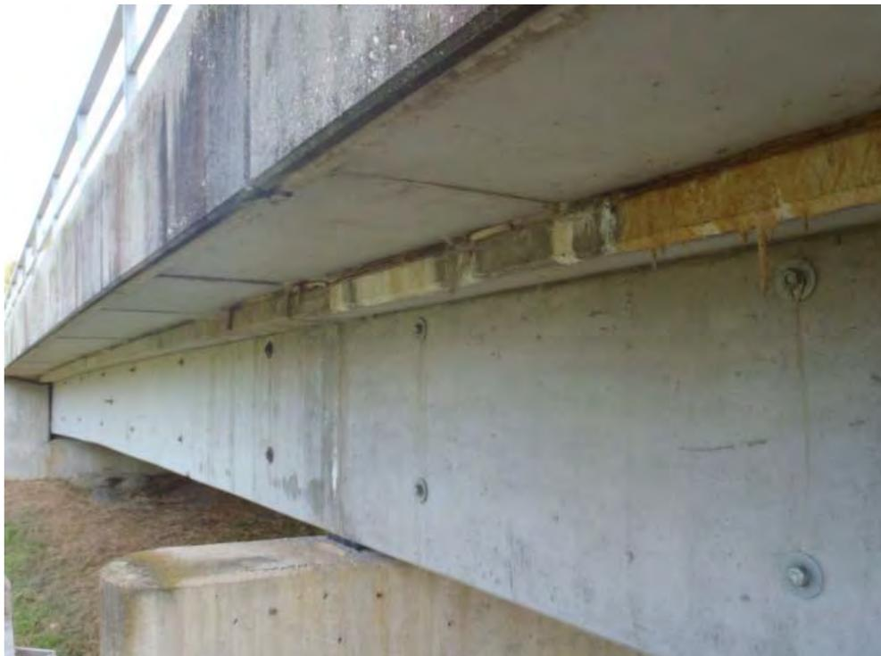
**Abbildung 2.63: Wasseraustritt, Aussinterungen und Salaktitenbildung am Längsträger**
