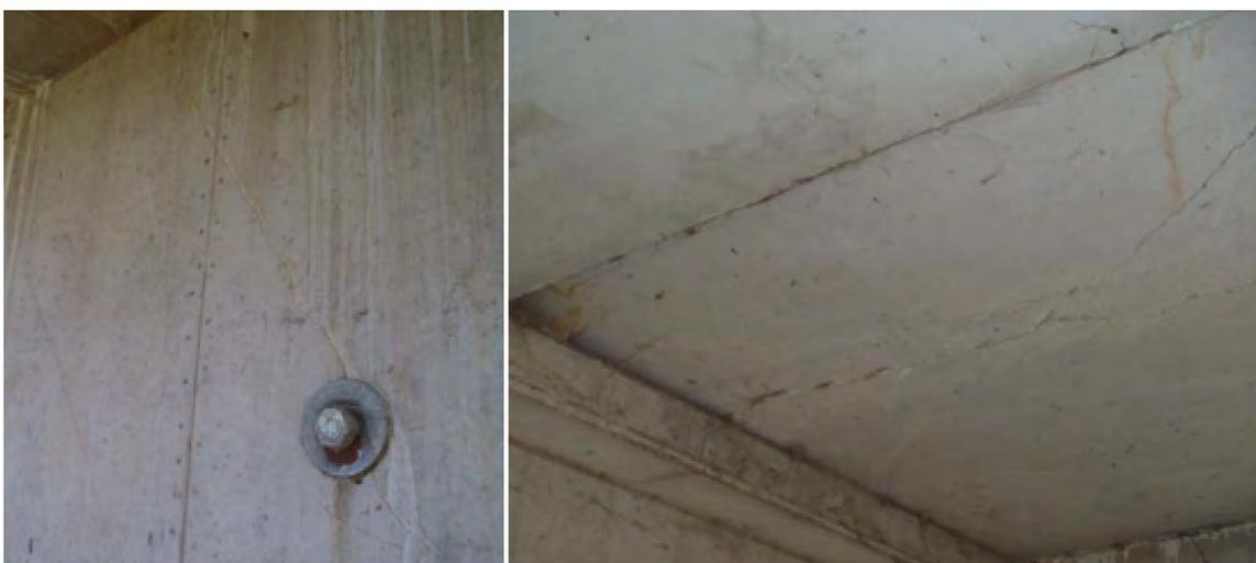
**Abbildung 2.65: Biegerisse in den Trägern (links) und durch Zwänge aufgestellte Fertigteilplatte (rechts)**
