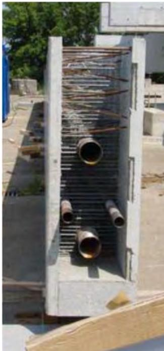
**Abbildung 2.54: Halbfertigteilträger aus Doppelwandelementen [1]**
