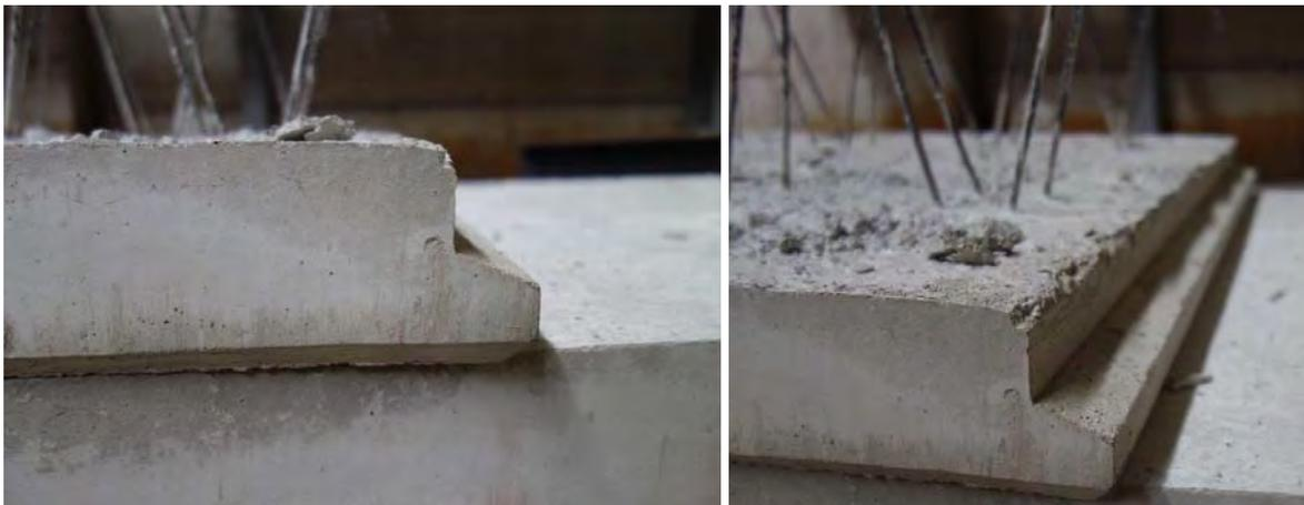
**Abbildung 3.30: Elementdecke mit speziell abgeschalteten Enden für schlaff bewehrte Fugen**
