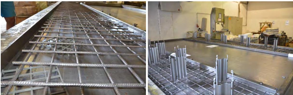
**Abbildung 3.50: Stahlmatten auf Abstandhaltern in der Stahlschalung (links); Eingelegte Stahlwellen als Verbindungselemente (rechts)**
