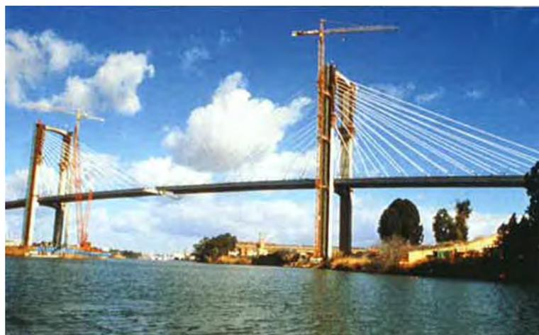
Abbildung 2.42: Schrägseilbrücke während der Errichtung [10]
