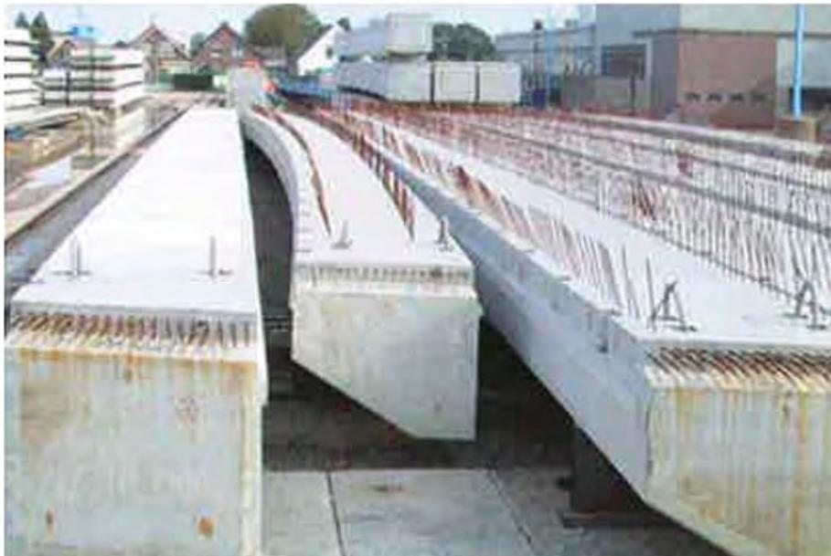
Abbildung 2.33: Gekrümmte Kastenträgerquerschnitte [10]
