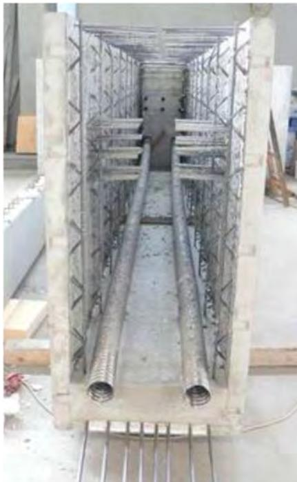
**Abbildung 2.53: Halbfertigteilträger aus Gitterträgerdecken [1]**
