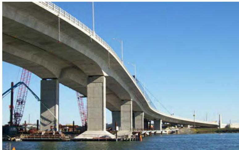
Abbildung 2.39: Segmentbrücke in New Jersey [14]
