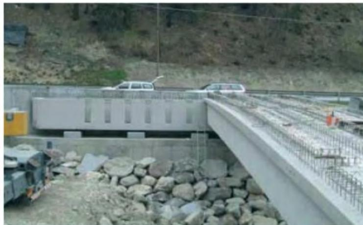
**Abbildung 2.52: Lagerung der FT-Längsträger [10]**
