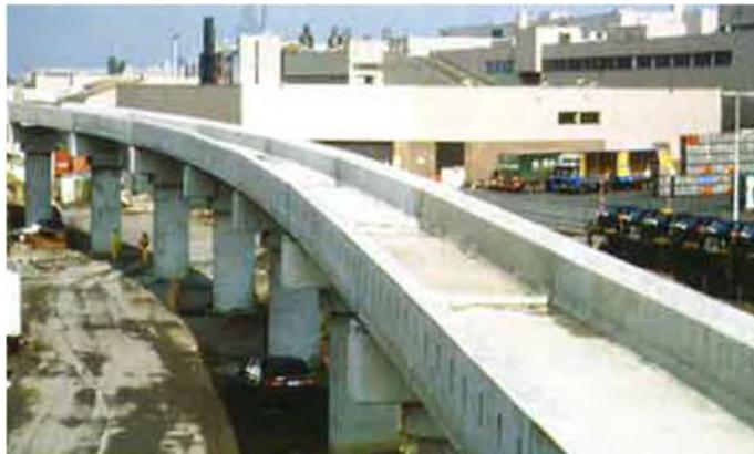
**Abbildung 2.37: Trogbrücke während dem Bau [10]**
