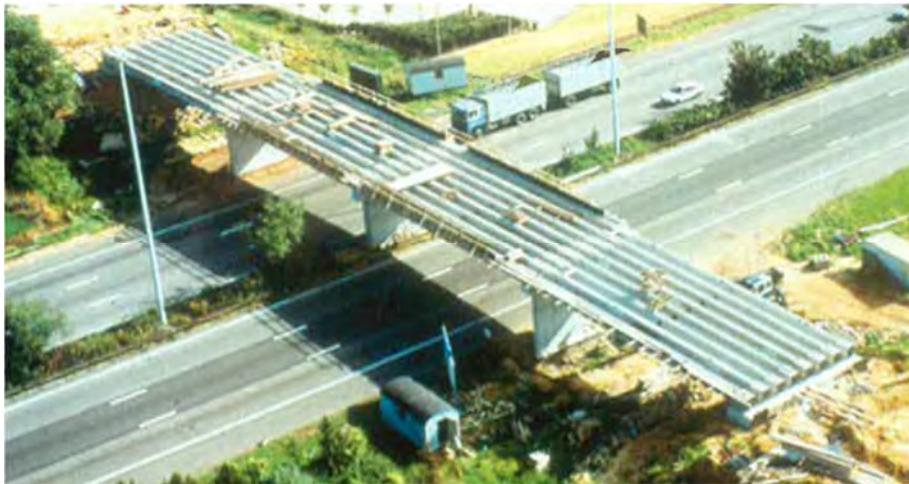
**Abbildung 2.27: Balkenträgerbrücke während der Errichtung [10]**
