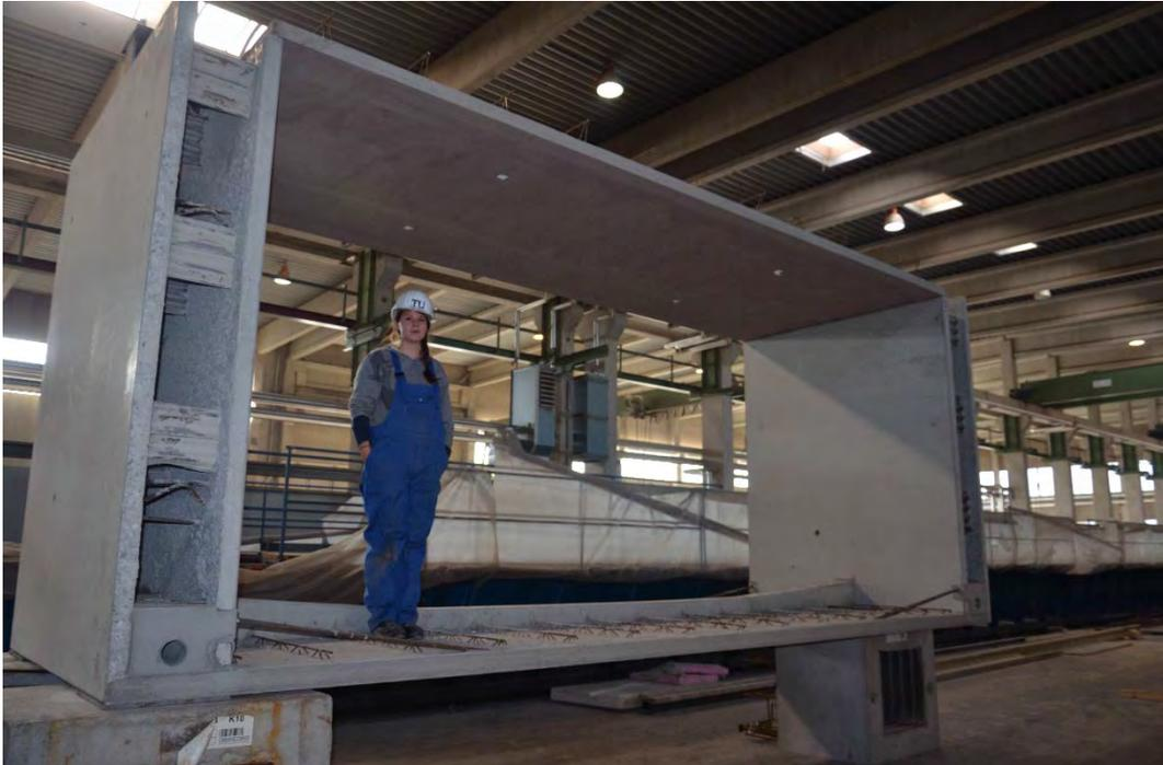
**Abbildung 2.55: Hohlkastenquerschnitt aus Doppelwandelementen und Gitterträgerdecken; Entwurf: TU Wien[17]**
