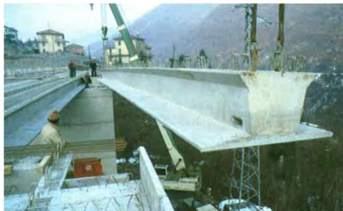
**Abbildung 2.29: Mono-Box-Träger während des Einhebens [10]**
