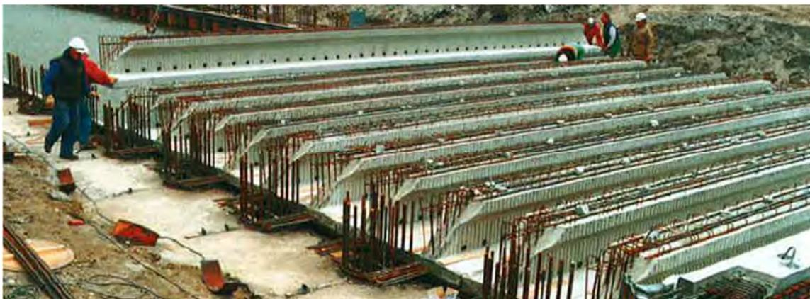
**Abbildung 2.25: Solid-deck-Brücke beim Einbau [10]**
