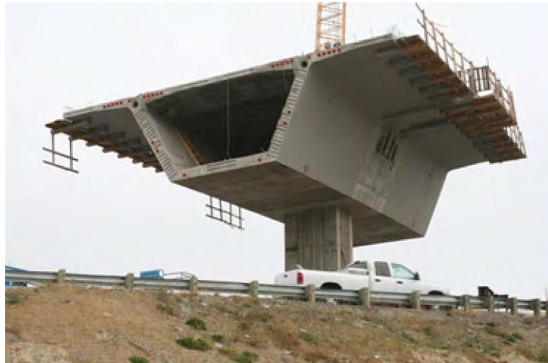
Abbildung 2.38: Segment bei der Errichtung einer Brücke [13]
