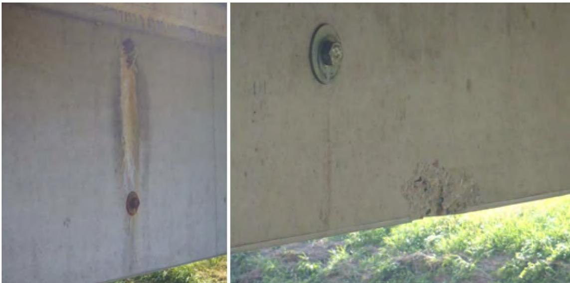
**Abbildung 2.64: Wasseraustritt und Stalaktitenbildung bei Ankerbolzverbindungen (links) und Betonabplatzung bei Mittelträgerpaar (rechts)**
