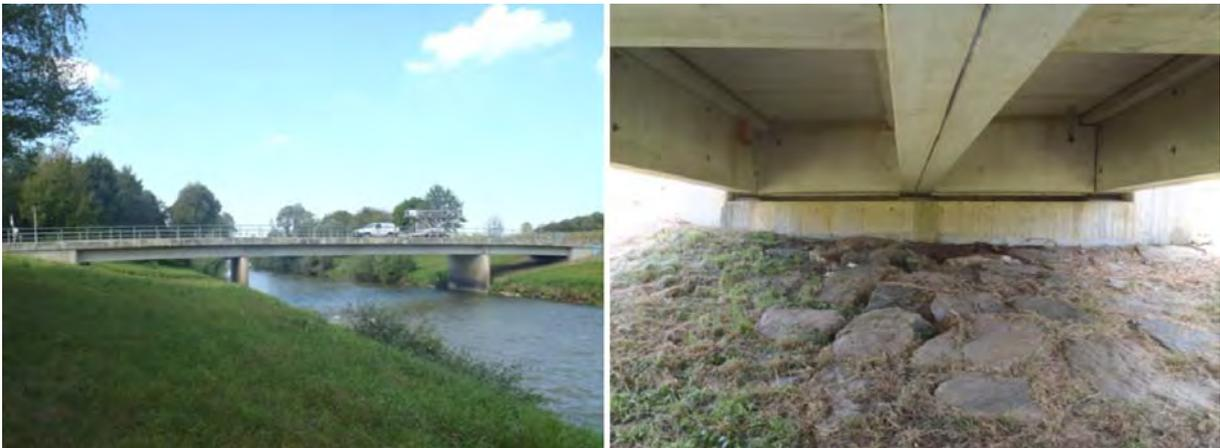
Abbildung 2.62: Ansicht (links) und Untersicht des Tragwerkes (rechts) einer Fertigteiltrübe in Österreich
