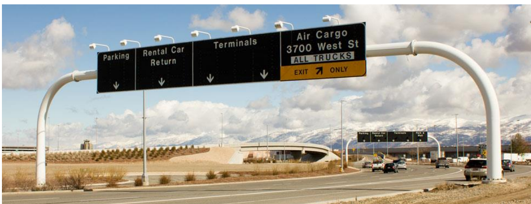
Abb. 3-2. Überkopfkonstruktion im Straßenverkehr in den USA. Tubular overhead, bridge supported. [72]
