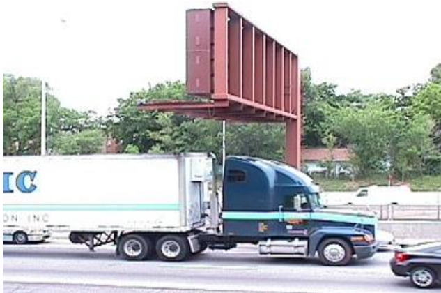
Abb. 3-1. LKW-Durchfahrt unter einem overhead cantilever-supported VMS [68]
