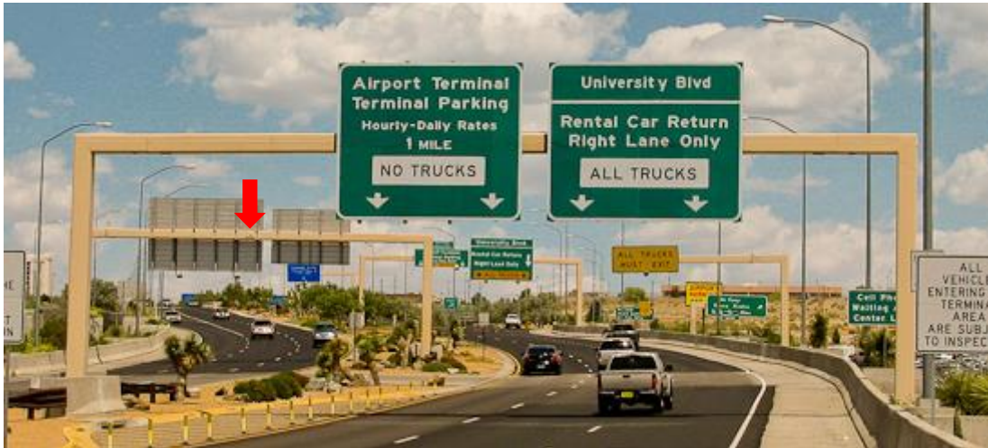
Abb. 3-5. Überkopfkonstruktion im Straßenverkehr in den USA.. Roter Pfeil: In etwa mit den österr. Mauterfassungssystemen vergleichbare Konstruktion. [72]
