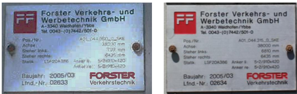
Abb. 4-1. Typenschilder an den Stationen A01_044,300_0_SKE (links) und A01_044,315_0_SKE (rechts)
