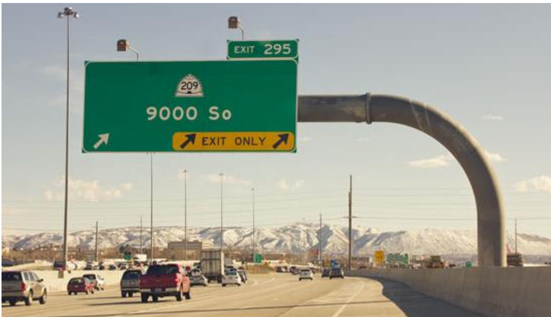
Abb. 3-4. Überkopfkonstruktion im Straßenverkehr in den USA. Monotube, cantilever supported. [72]
