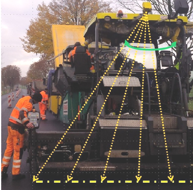
Abbildung 14. Messprinzip des PAVE-IR Systems.
