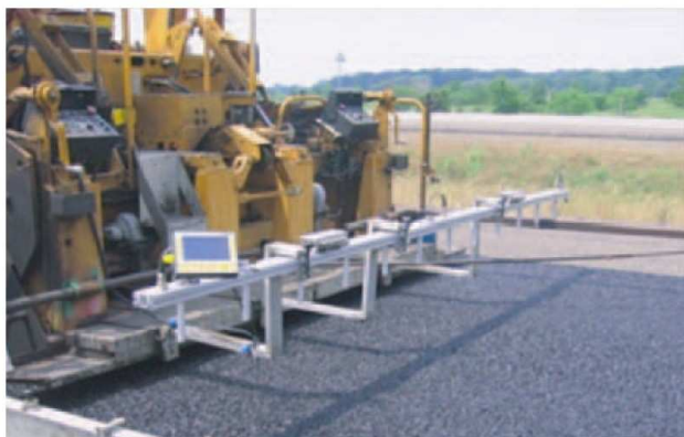
Abbildung 9. MOBA PAVE-IR Messbalken (Sebesta et al., 2013).
