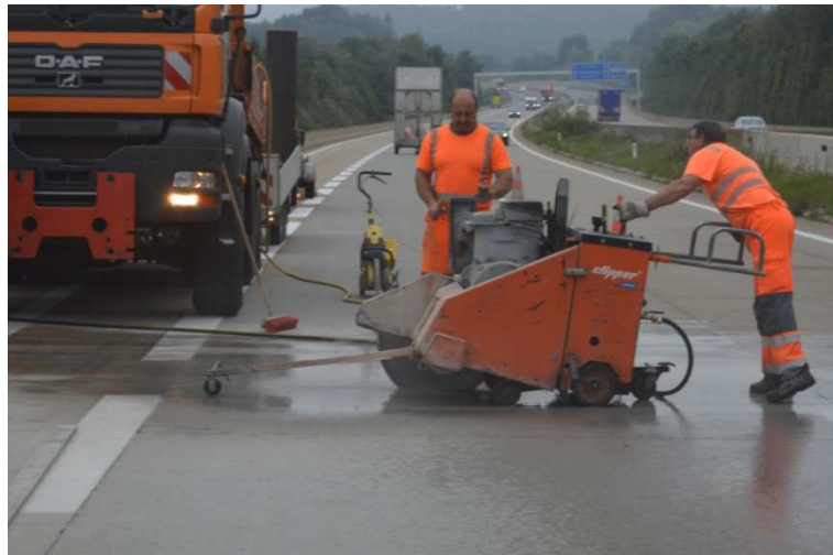
Abbildung 31: Schneiden des Betons
