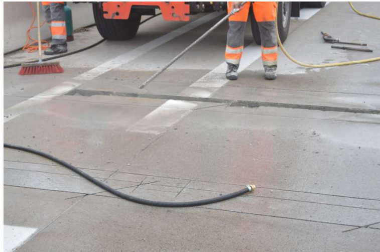
Abbildung 32: Reinigung des ausgebrochenen Bereiches
