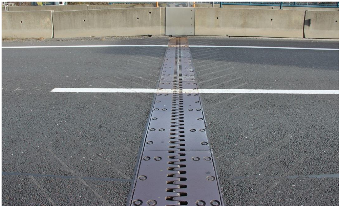
Abbildung 5-1: FÜK (Fingerübergang-auskragend), A10, km 141, Brückenobjekt L53
