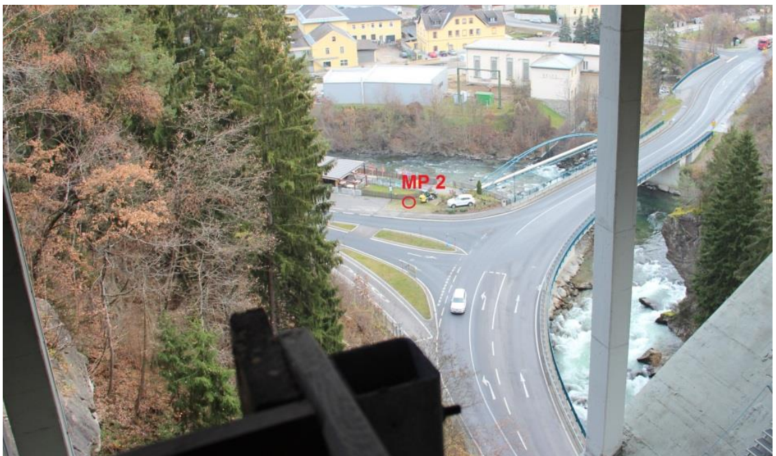
Abbildung 5-16: Lage des Schallimmissionspunktes MP2 unterhalb der Fahrbahnübergangskonstruktion.
