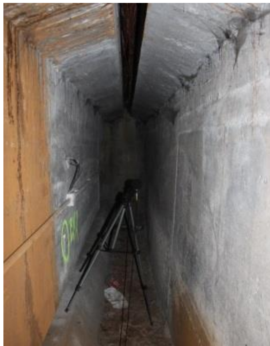
Abbildung 5-4: Messort A 10, km 141, Messpunkt unter der Brücke/FÜK
