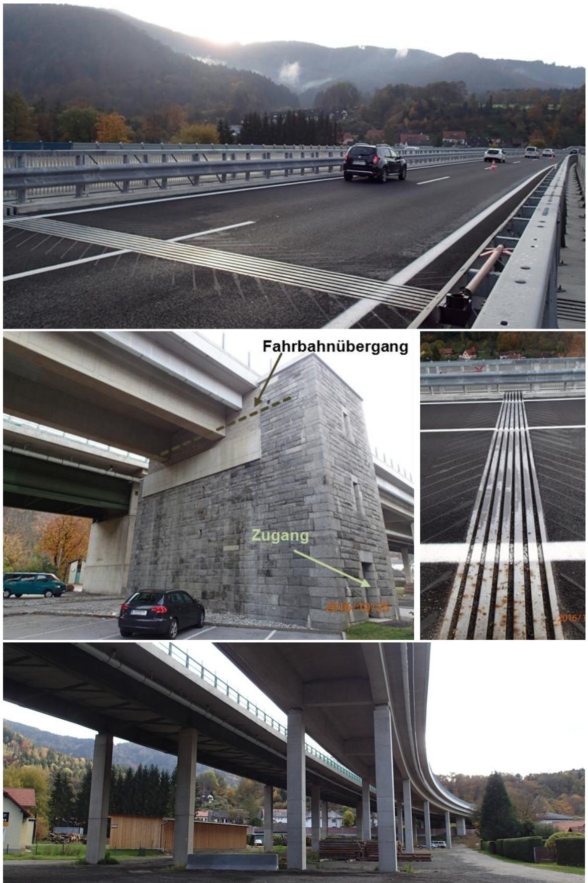
Abbildung 5-25: Darstellung des Fahrbahnüberganges der S35 Brücke Frohnleiten.
