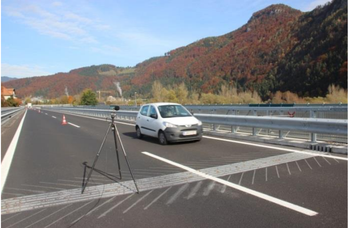
Abbildung 5-29: S34, km 24,3 Objekt 6781F3, Messpunkt im Übergang ( d=3,75\text{m} / h=1,2\text{m} )
