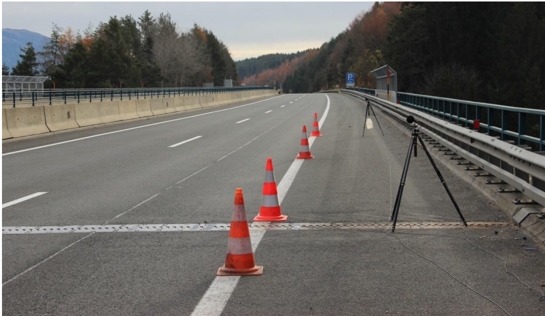
Abbildung 5-3: Messort A 10, km 141, Referenzmesspunkt und Messpunkt im Übergang ( d=3,75\text{m} / h=1,2\text{m} )
