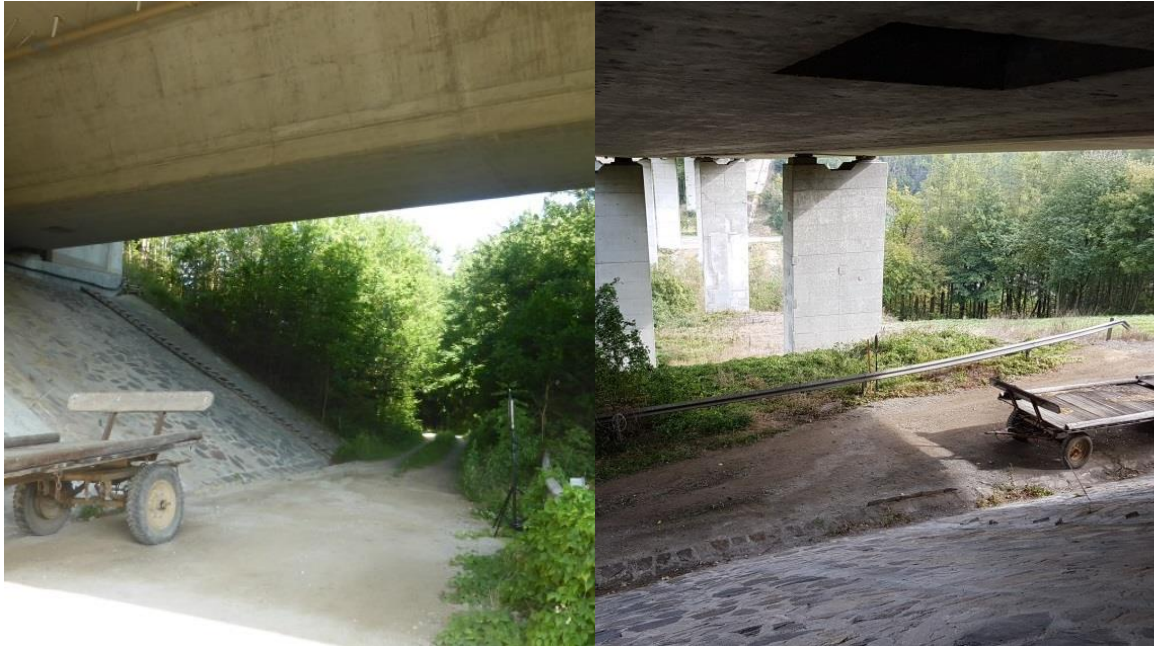
Abbildung 5-66: Lage des Schallimmissionspunktes MP1 im Nahbereich der Fahrbahnübergangskonstruktion
