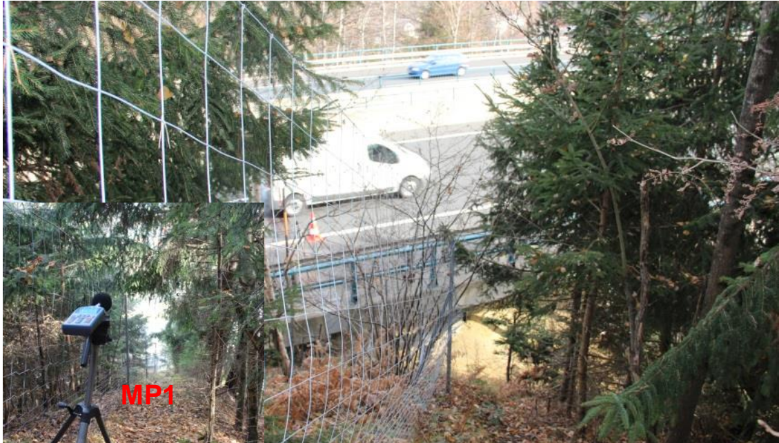
Abbildung 5-15: Lage des Schallimmissionspunktes MP1 oberhalb der Fahrbahnübergangskonstruktion
