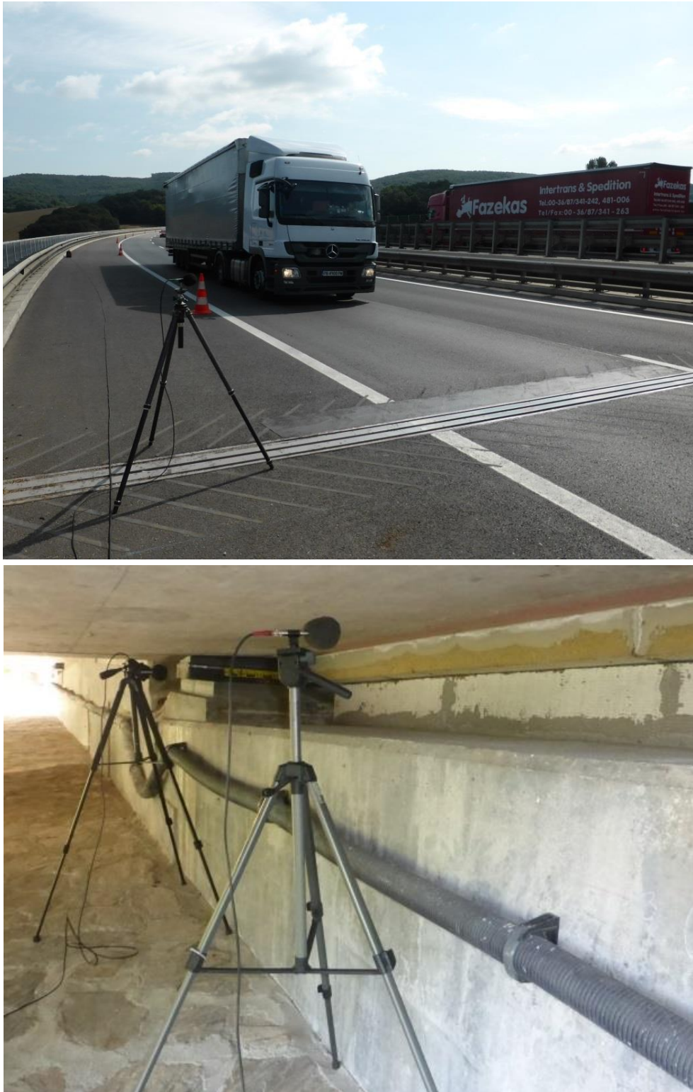
Abbildung 5-51: Messort A 21, km 19,57, Messpunkt im Übergang ( d=3,75\text{m} / h=1,2\text{m} ) sowie Messpunkte unter der Brücke (Zustand mit Dämmmaterial am 20.07.2016)
