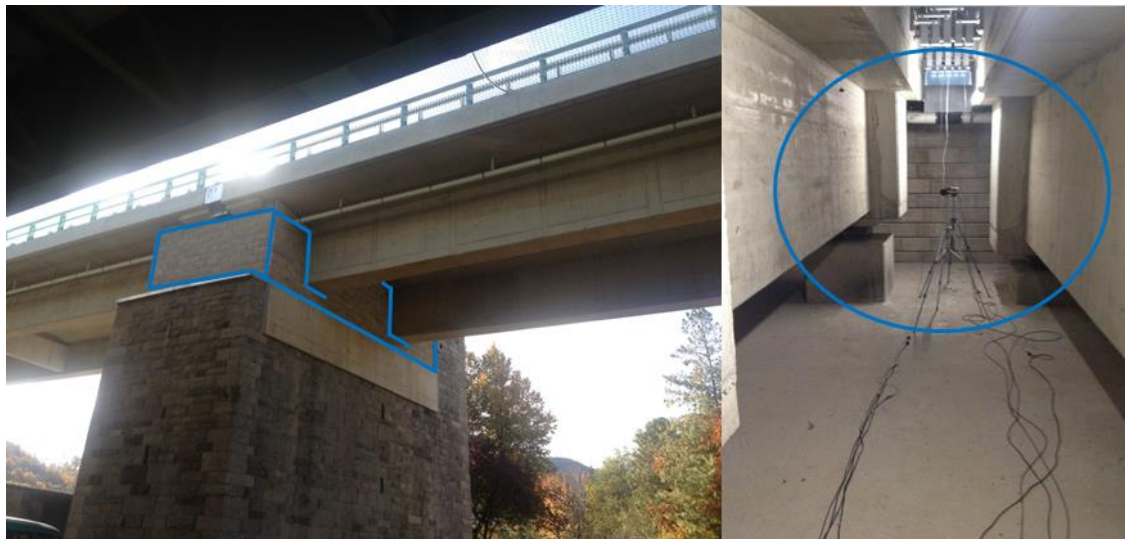
Abbildung 5-32: S34, km 24,3 Objekt 6781F3, Einhausung
