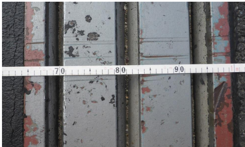
Abbildung 5-50: FÜK (Lamellenübergang), A21, km 19,57, Öffnungsbreite: 35,8cm, 20.07.2016
