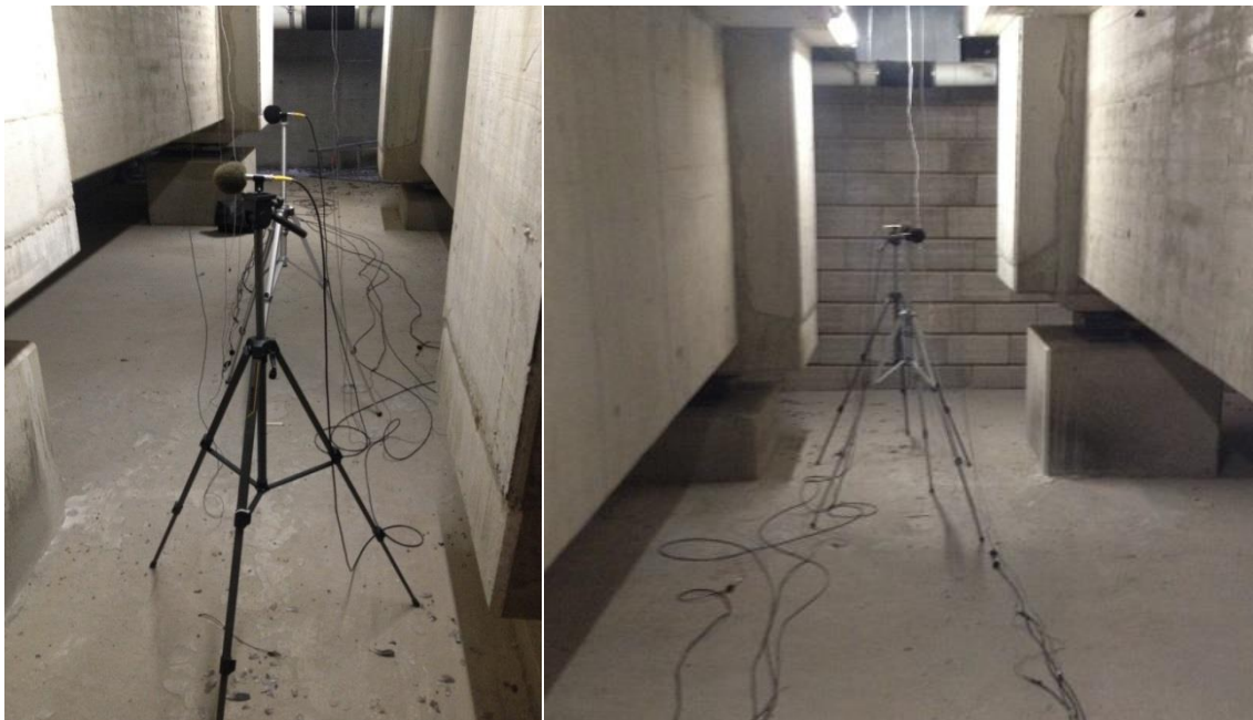
Abbildung 5-31: S34, km 24,3 Objekt 6781F3, Messpunkt2 unter der Brücke/FÜK
