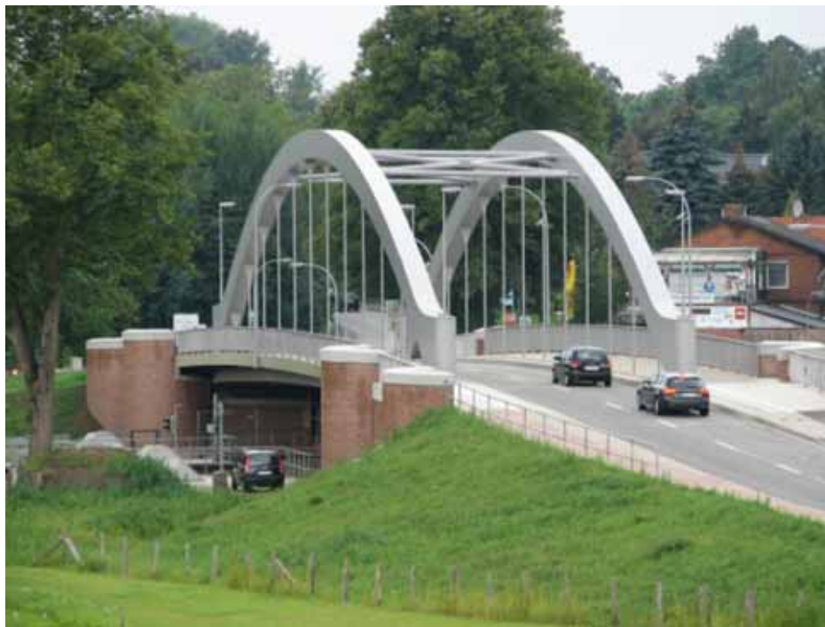
Abbildung 7: Kanalbrücke Berkenthin von Osten (aus [44])
