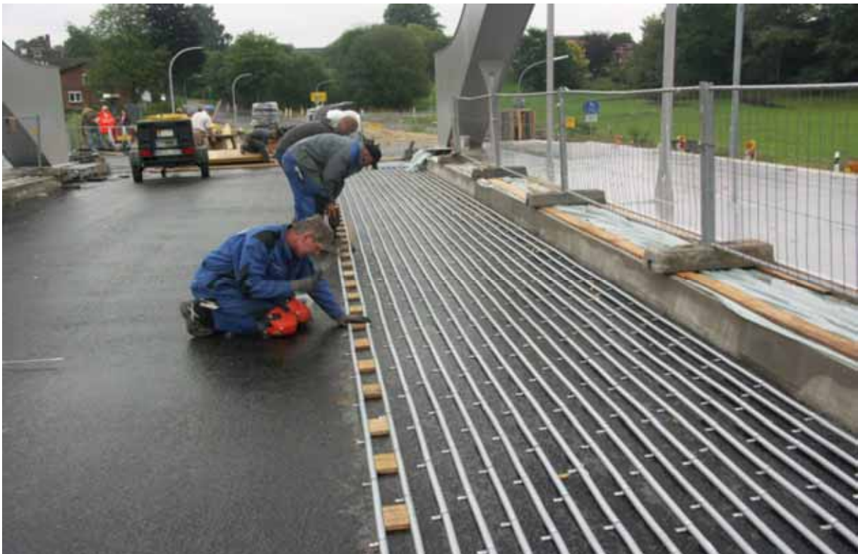
Abbildung 10: Foto der Bauarbeiten bzw. Verlegearbeiten der Brücke Berkenthin (aus [44])
