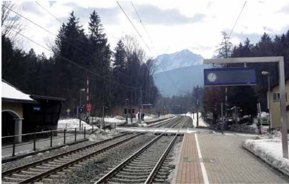
Abbildung 90: Verkehrsstation Bad Vigaun
