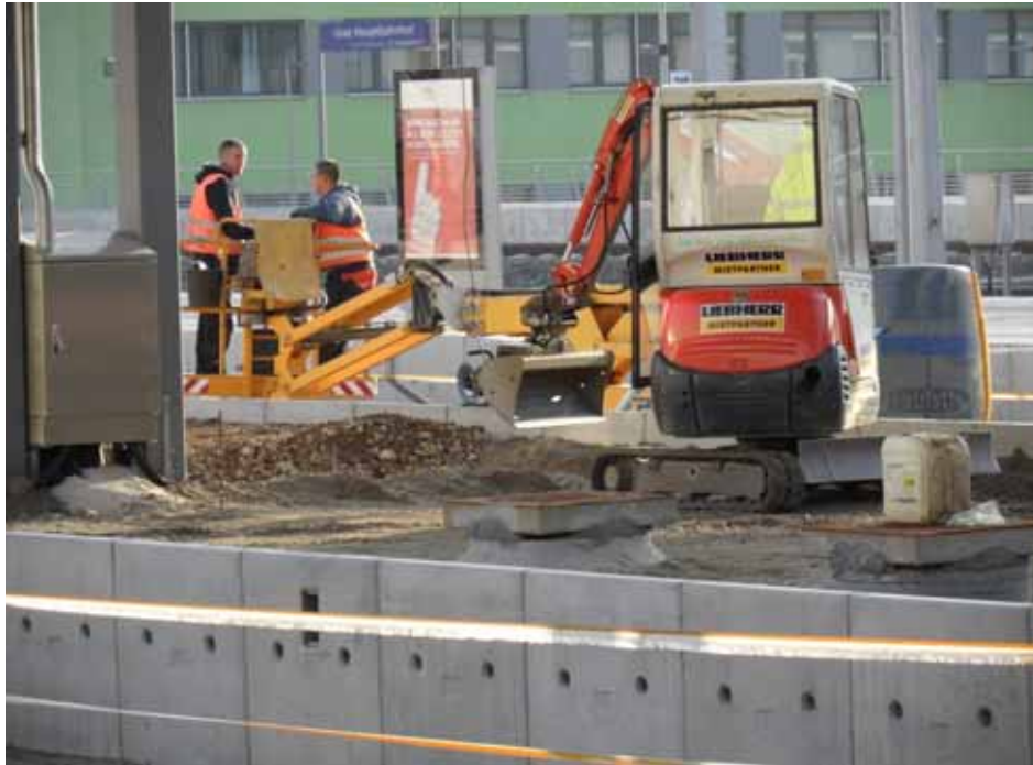
Abbildung 56: Bahnsteigerstellung – Hauptbahnhof Graz
