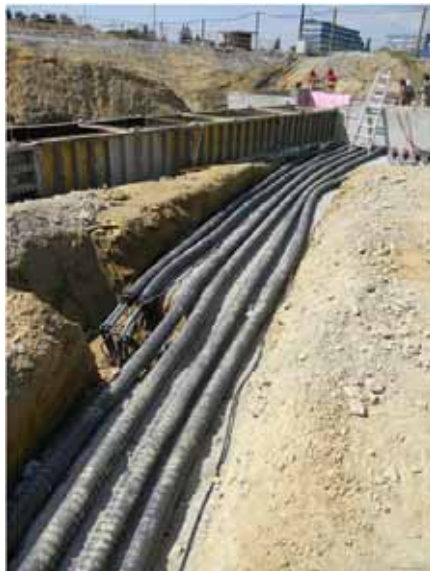
Abbildung 32: Bau eines Erdwärmesondenfeldes (Fotos: G. Domberger)
