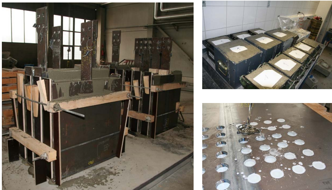
Abbildung 10: Betonierarbeiten der Vorversuchskörper; links: Vorversuchskörper nach der Betonage; rechts: Probewürfel und temporäre Versiegelung von Öffnungen mit Wachs
