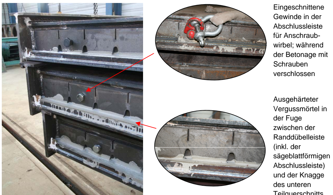
Abbildung 28: Vorbereitungen an den Stahlteilen der SCSC-Hauptversuchskörper vor der Betonage des Kernbetons
