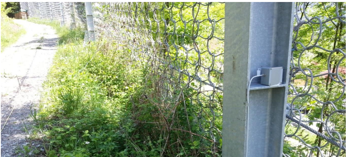
Abbildung 26: Geophon an Steinschlagschutznetz
