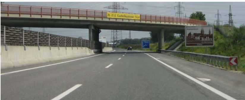
ABB 1. Vorschriftsmäßige Absicherung eines Brückenpfeilers auf der Autobahn
