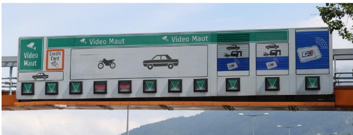
Abbildung 10: Beschilderung im Detail an der Maut-Gantry
