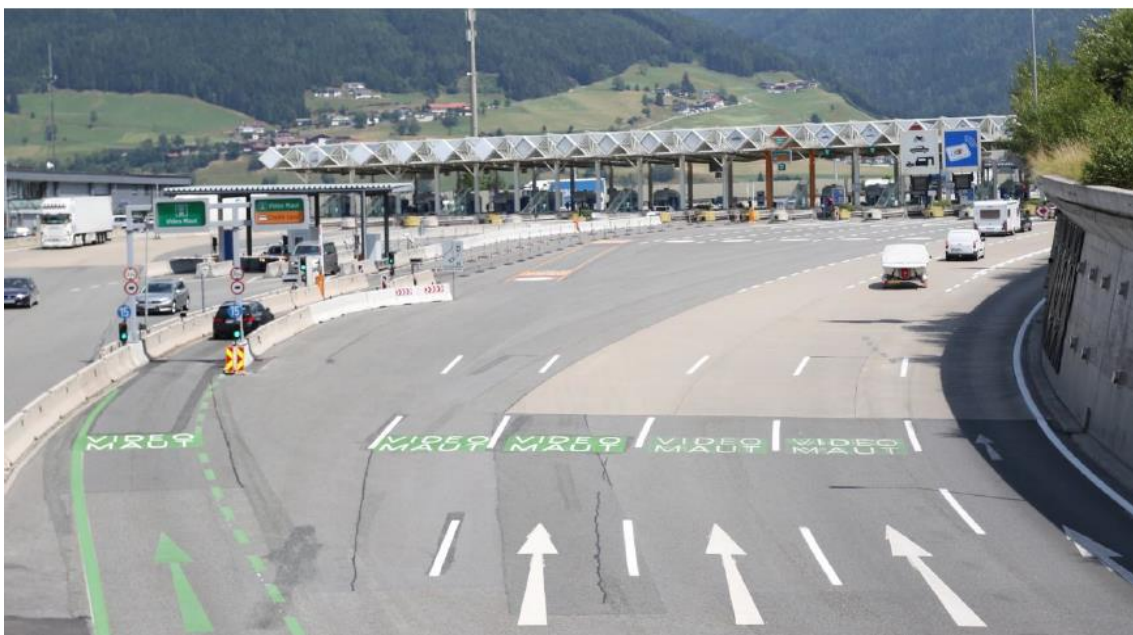
Abbildung 12: Bodenmarkierung „Video Maut“ im Detail
