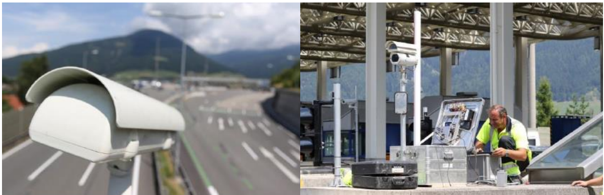
Abbildung 5: System 3 – Fußgängerbrücke (links); System 4 – Mautstation (rechts)
