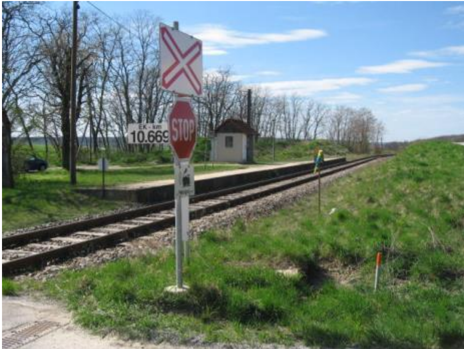
Abbildung 24: Das Testobjekt bei der Eisenbahnkreuzung in Raggendorf
