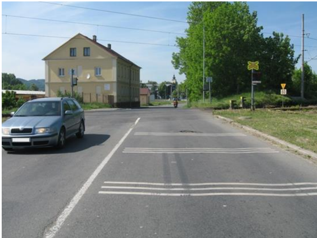
Abbildung 4: Rüttelstreifen bei der Eisenbahnkreuzung in Šumperk (ČR)
