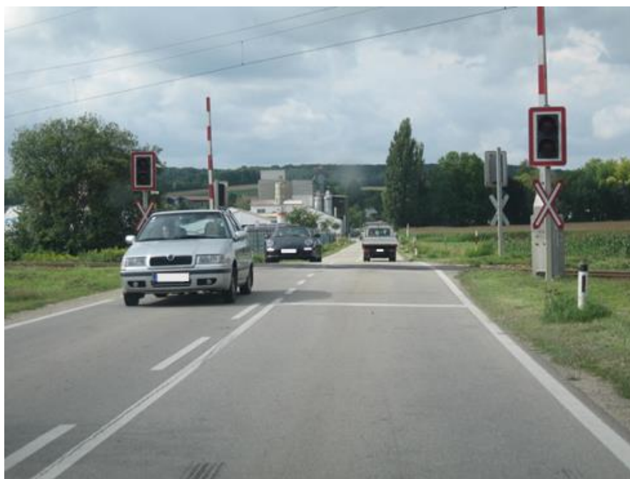
Abbildung 6: Eisenbahnkreuzung Göllersdorf, Bahn km 42,515
