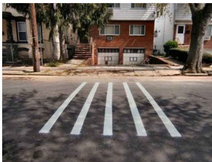
Abbildung 3: Rüttelstreifen als eine verkehrsberuhigende Maßnahme in Newark (USA)
