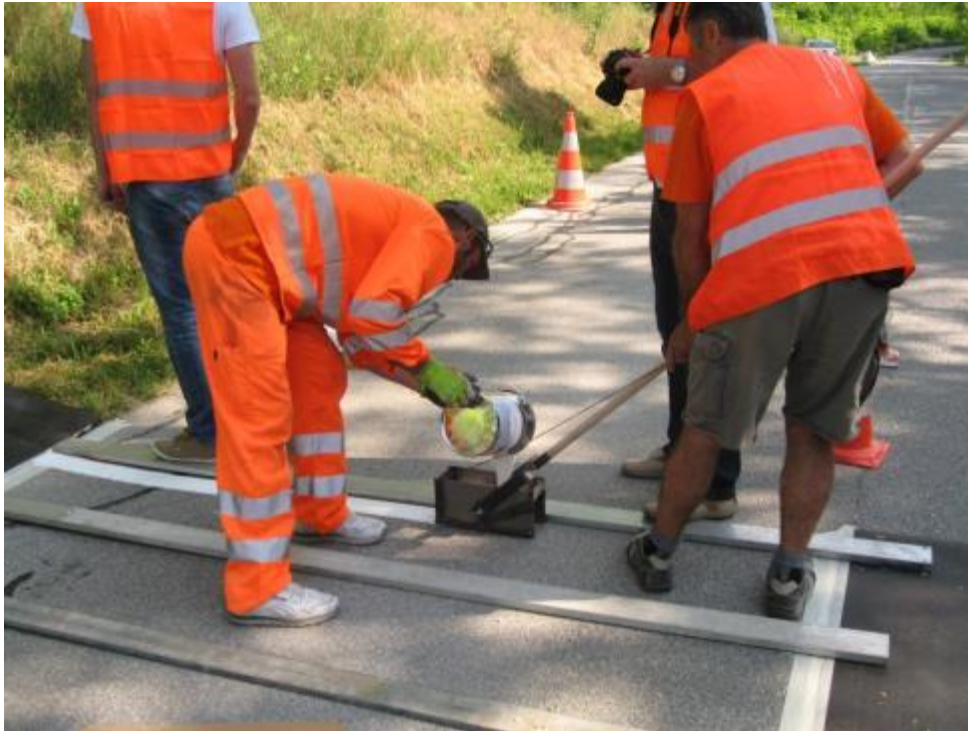
Abbildung 13: Beginn der Arbeiten in Raggendorf, Seite Matzen (Kaltplastik)
