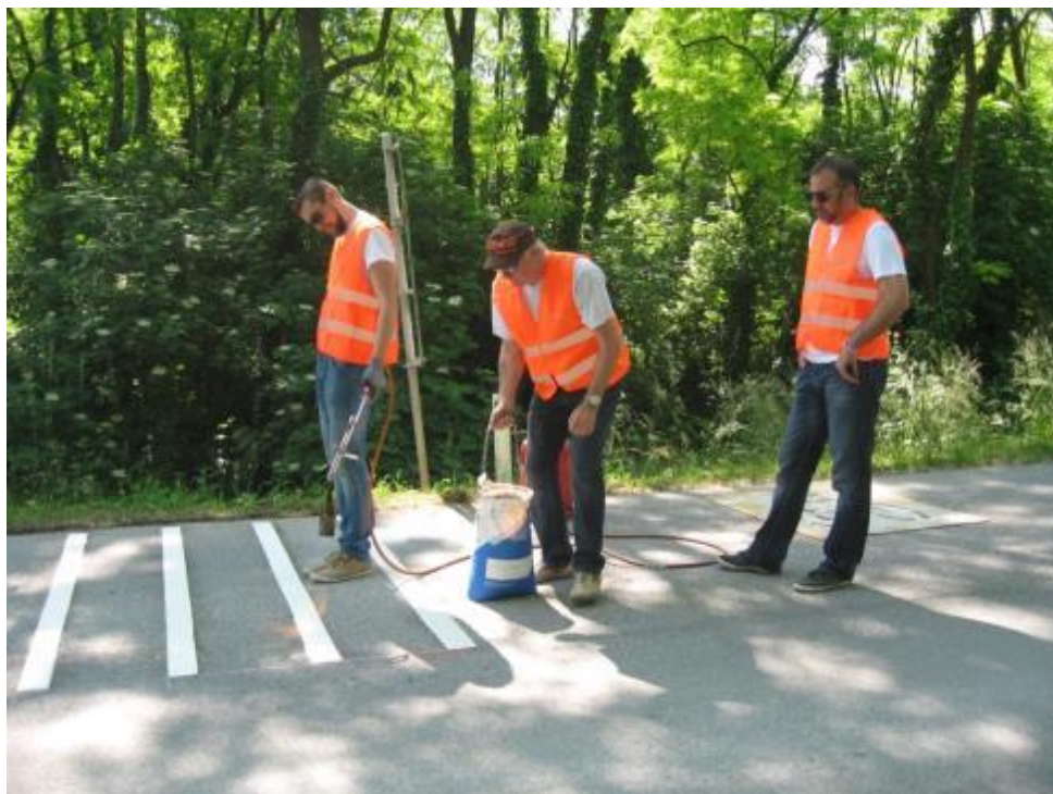
Abbildung 14: Die Seite Raggendorf, Verlegung des ersten Rüttelstreifens (Heißplastik)
