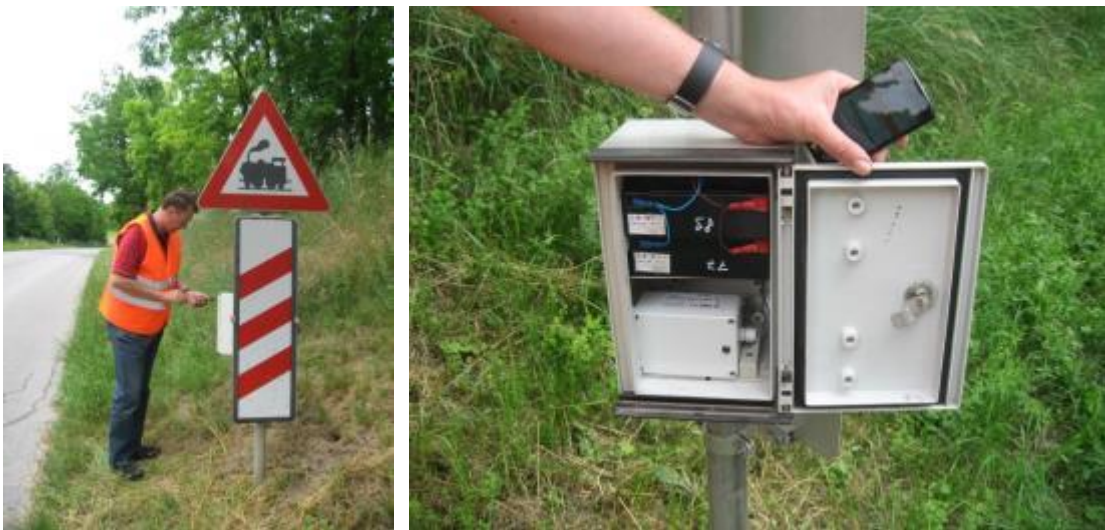
Abbildung 15: Einstellung der Funktionalität der montierten Radargeräte
