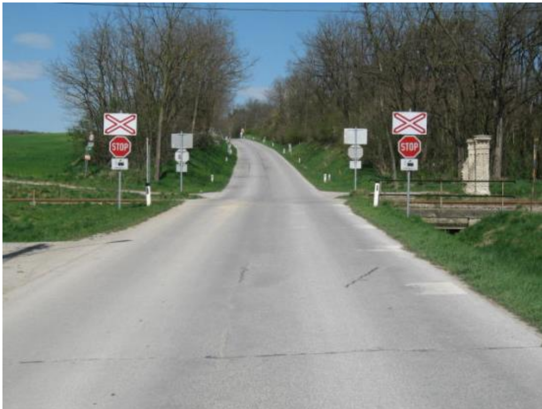
Abbildung 35: Eisenbahnkreuzung nichttechnisch gesichert (Raggendorf)
