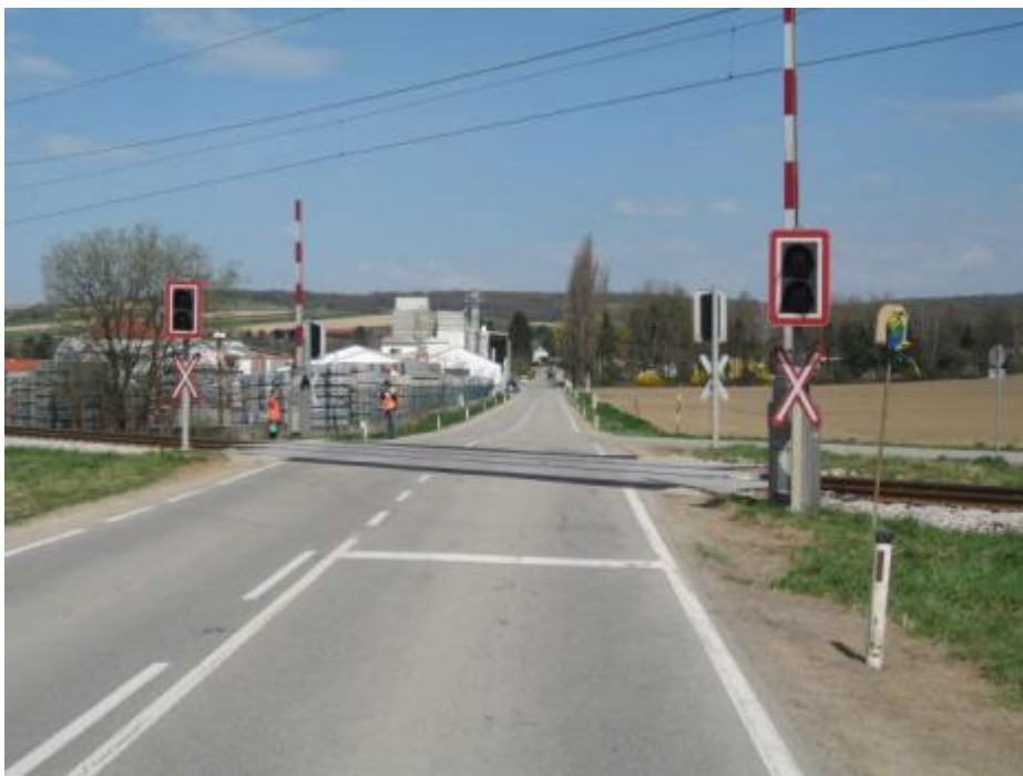
Abbildung 25: Das Testobjekt bei der Eisenbahnkreuzung in Göllersdorf
