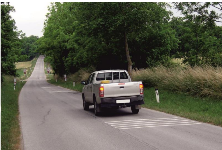
ABB 1. Teststrecke Rüttelstreifen bei der Eisenbahnkreuzung in Raggendorf
