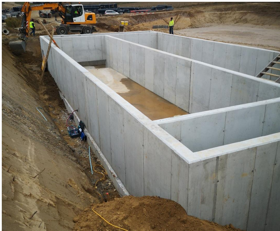
Abbildung 50: Ansicht des Absatzbeckens mit Gaspermeabilitätsmessung im Wandbereich „mittel“
