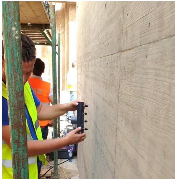
Abbildung 38: Messung des elektrischen Widerstandes auf der Baustelle
