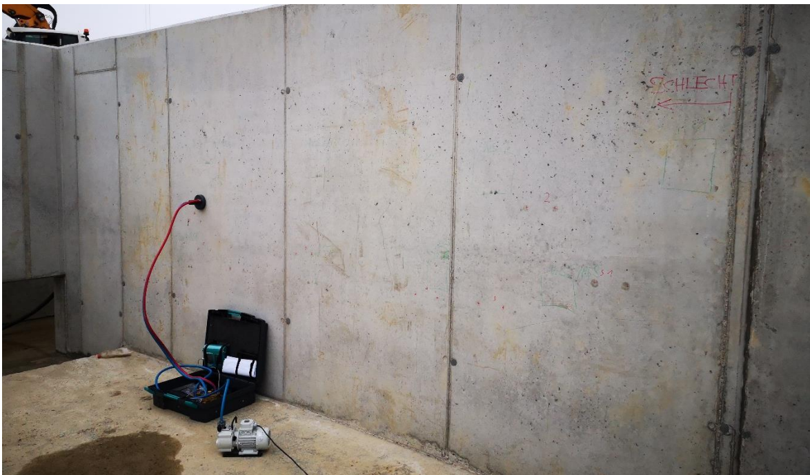
Abbildung 51: Gaspermeabilitätsmessung im Wandbereich „schlecht“
