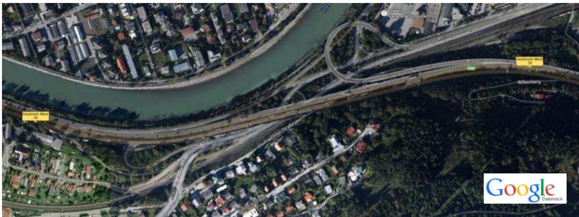
Abbildung 16: Anschlussstelle Innsbruck-West - Anschlussstellenform Sonstige
