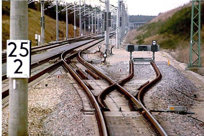
Abb. 2-6: Auffangweiche mit Stumpfgleis und Gleisabschluss (vgl. [7])
