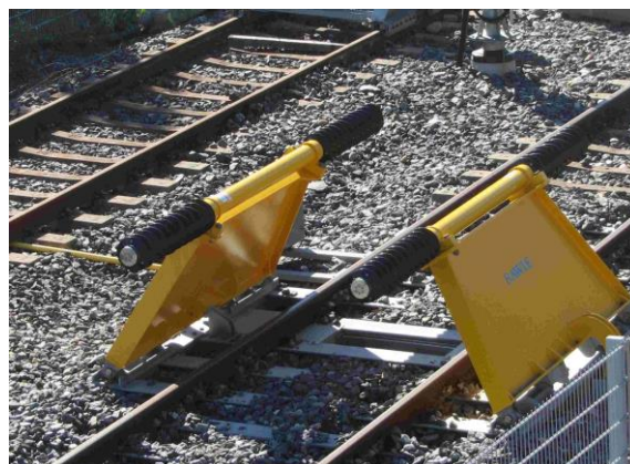
Abb. 2-11: Hydraulisch Klappbarer Prellbock in Helsinki, Finnland (vgl. [15])
