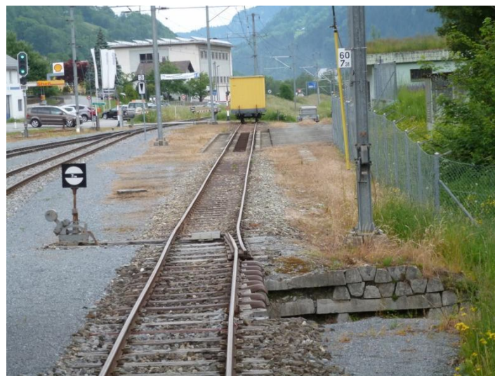
Abb. 2-8: Entgleisungsvorrichtung mittels Unterbrechung der Schiene (vgl. [11])
