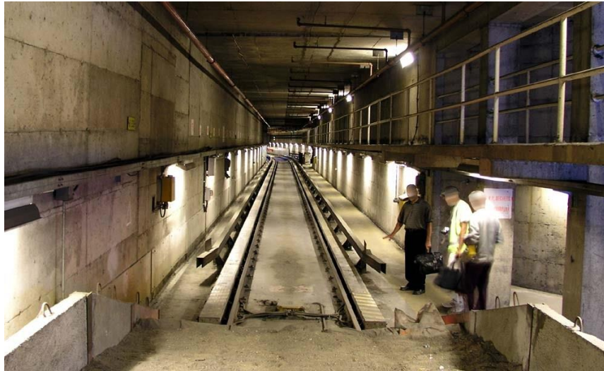
Abb. 2-7: Abstellgleis der Métro Montréal – Ende des Gleises eine Sandgrube als Prellbock-Ersatz (vgl. [10])
