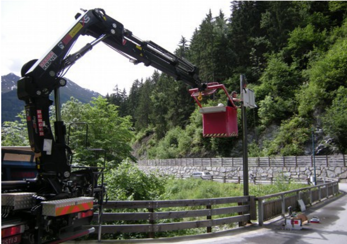
Abbildung 13: Montage des Radars am Standort
