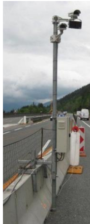
Abbildung 8 :Beispiel für Masthaltung auf einer Betonleitwand samt Rohrsteher und Videokamera
