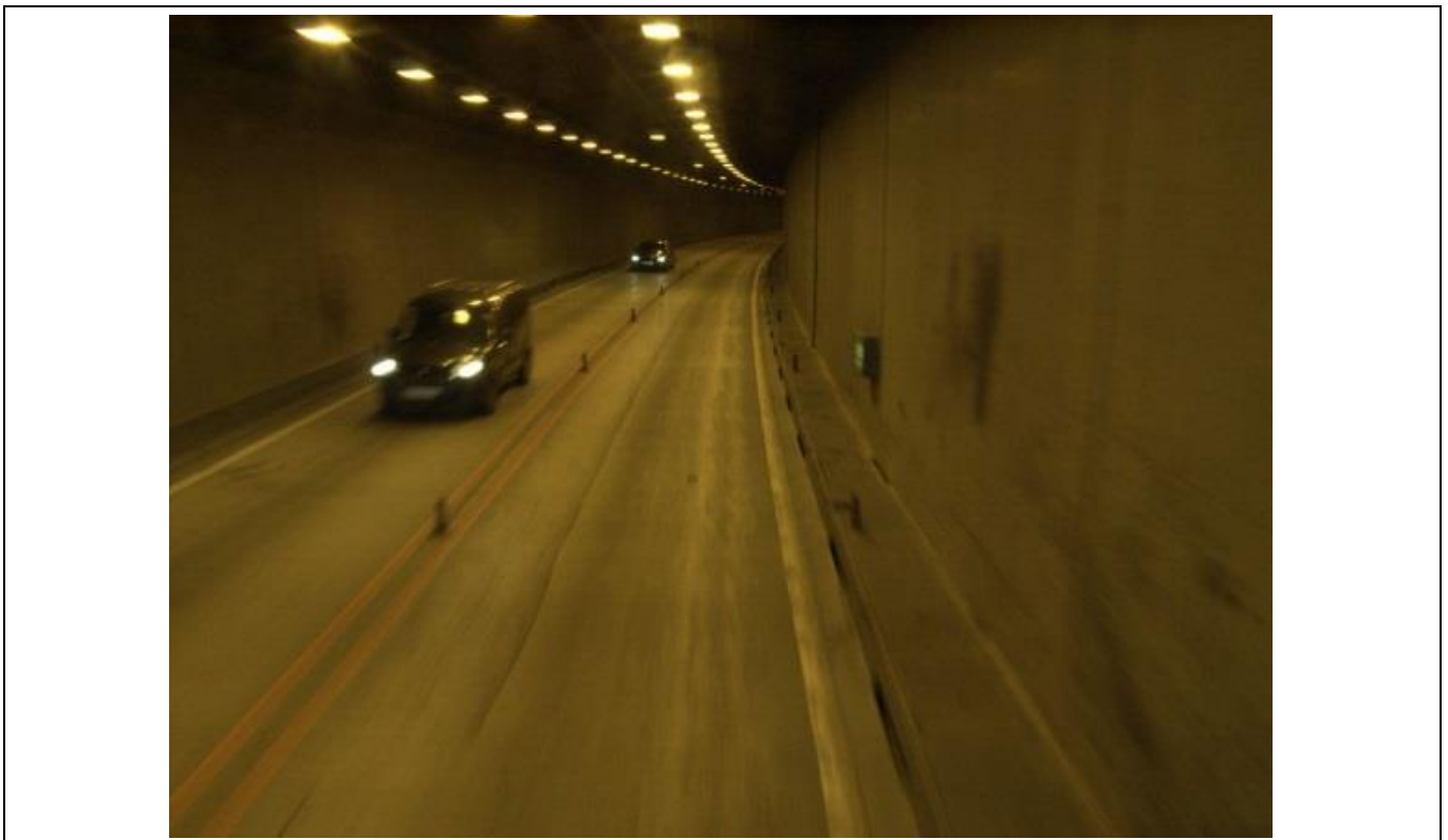
Foto 4-1: Ehrentalerberg Tunnel – Gegenverkehrsbereich mit Fahrbahnteiler
