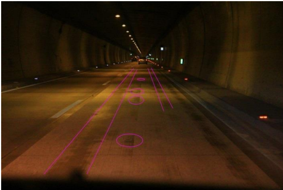
Foto 4-2: Unbehandelte Bereiche nach dem Grinding aufgrund vorhandener Einbauten und Spurrinnen.
