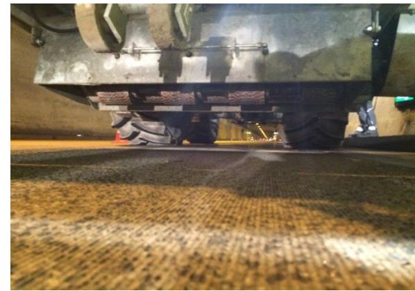
Foto 3-5: Rotationsfräsung
