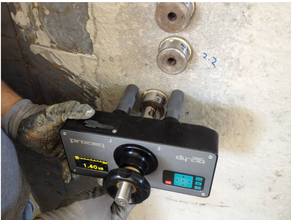
Abbildung 118: Prüfung der Abreißfestigkeit durch zentrisches Abziehen eines geklebten Stahlstempels von einer durch eine ringförmige Bohrung begrenzten Betonoberfläche.
