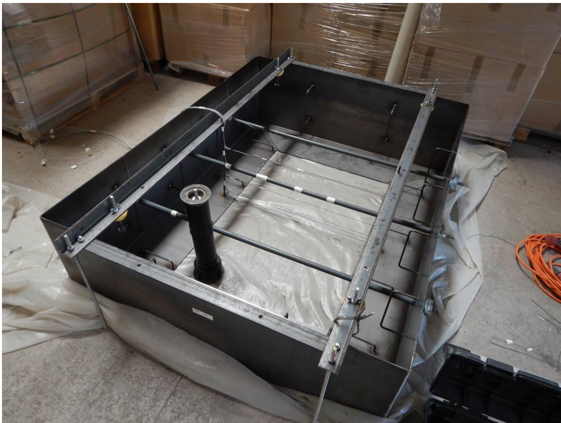
Abbildung 106: Vorbereitungen der Schalung für die Betonage
