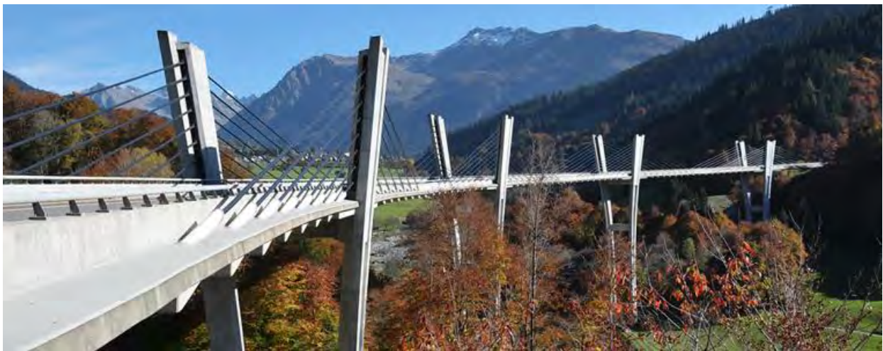
Abbildung 1: Beispiel einer integral ausgeführten Brücke (Sunnibergbrücke) [1]
