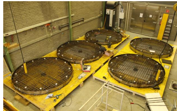
Abbildung 4.11: Platten vor Betonage
