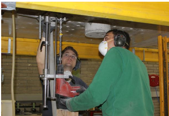
Abbildung 4.16: Bohren Schraubenlöcher
