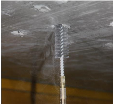
Abbildung 4.18: Reinigen der Löcher
