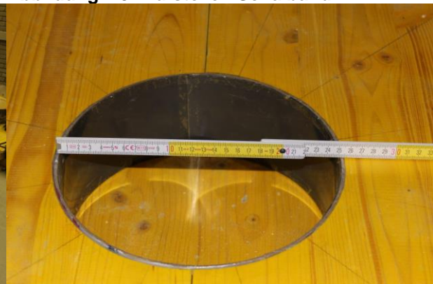
Abbildung 4.7: Schalung Stützenstummel
