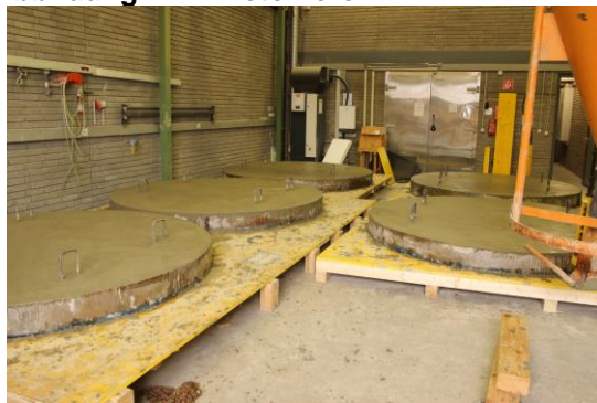
Abbildung 4.14: frisch betonierte Platten
