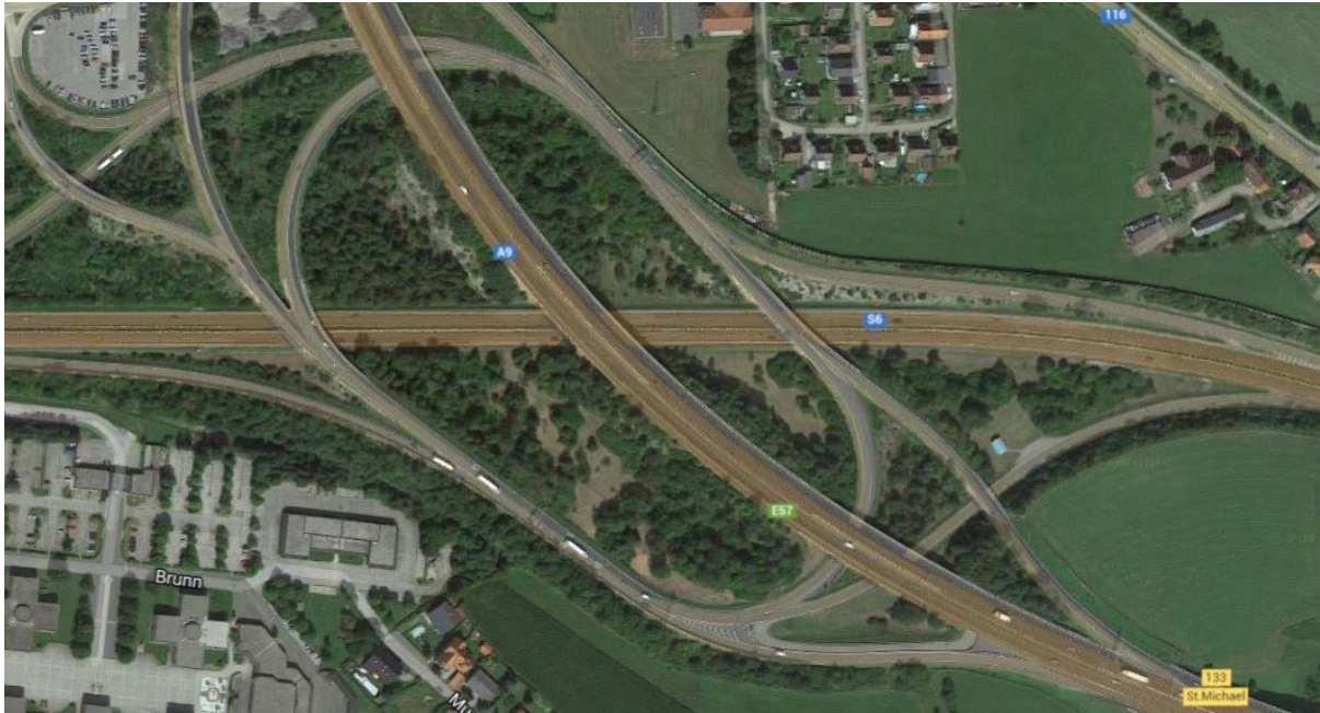
Abbildung 2-7: Luftbild Kreisverkehr Pyhrn Autobahn, A9 Knoten St. Michael [19]
