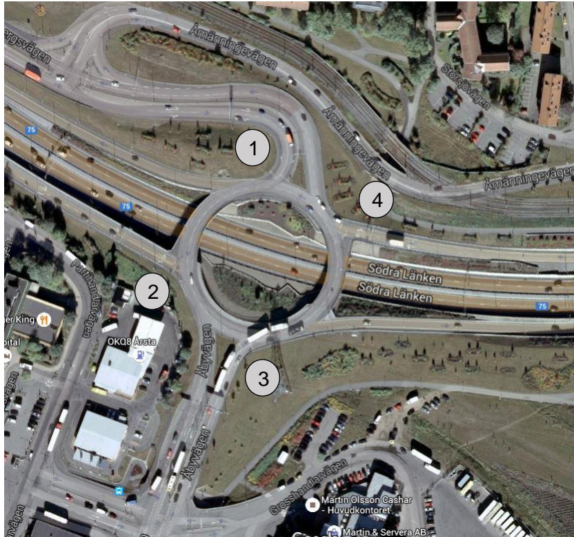
Abbildung 2-9: Luftbild Kreisverkehr Stockholm, Södra Länken – Abyvägen [19]
