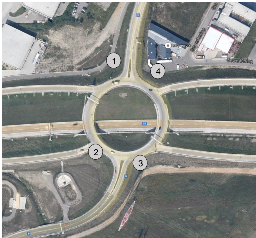
Abbildung 2-2: Luftbild Kreisverkehr Wiener Außenring Schnellstraße S1 bei Korneuburg [19]
