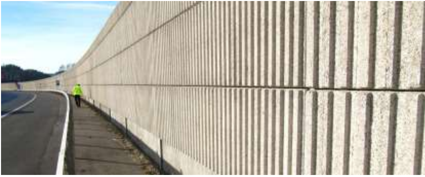
ABB 1. Begehung einer Lärmschutzwand im Zuge einer Messkampagne als Beispiel für eine Abnahmeprüfung und Qualitätssicherung der gebauten Lärmschutzwand.
