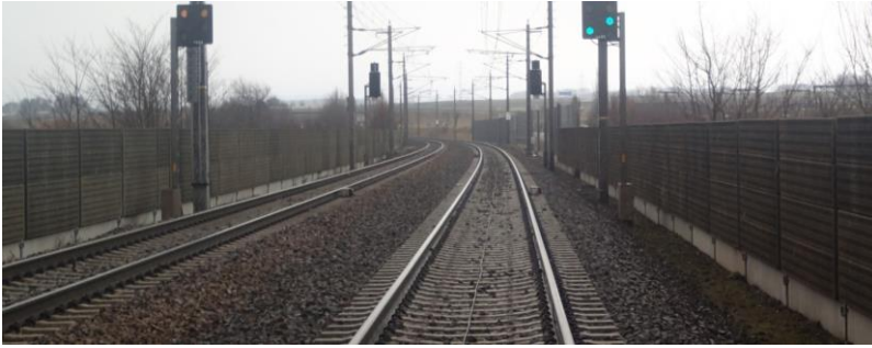
ABB 2. ÖBB Westbahnstrecke unmittelbar nach Schotterflugereignis
