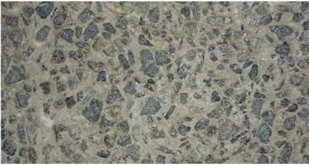
Abbildung 2: Typische Waschbetonstruktur von Straßenoberbeton
