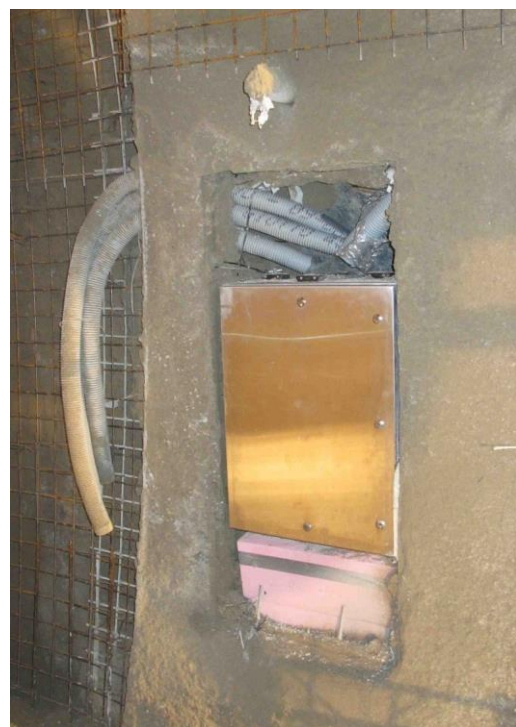
(b) Freigelegte Kabelanschlussbox nach dem Einspritzvorgang
