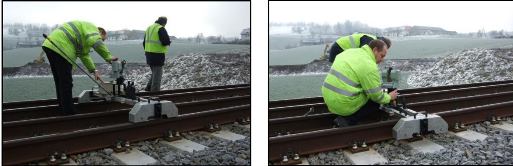
(Abbildung 4.7 und Abbildung 4.8: Gleismesswagen)
