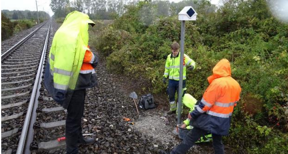
Abbildung 15: Befestigung der Masten
