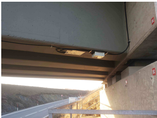
Abbildung 8: Feldversuche in Großhaslau, FBG-Sensorik(links), Messzentrale (links)
