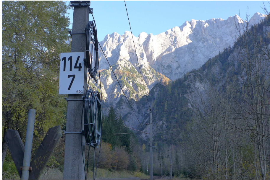
Abbildung 3: Verlegeart Lufthängekabel
