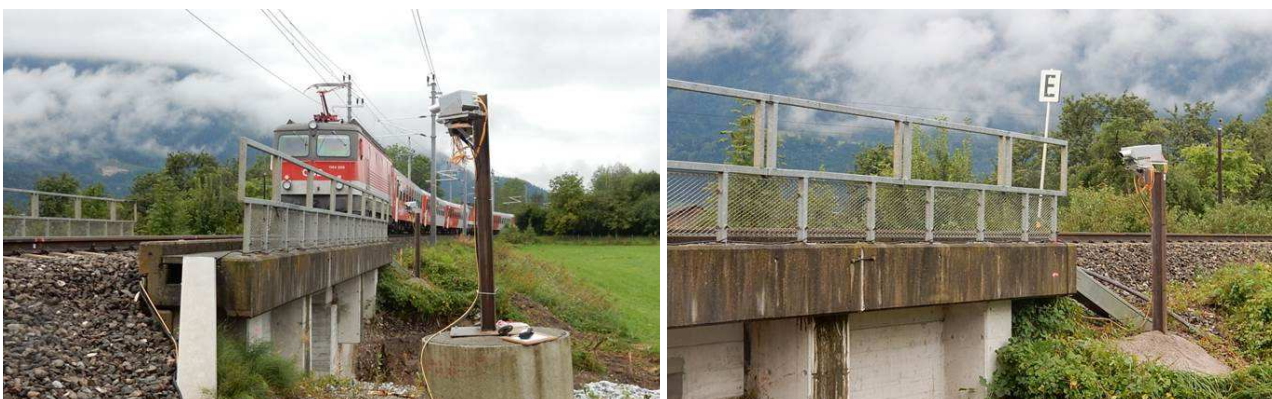
Abbildung 1 und Abbildung 2: Setzungsbeobachtungen mit FOS in Liezen.
