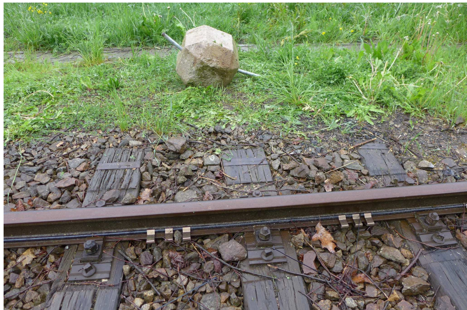
Abbildung 4: Verlegeart Schienenfußkabel
