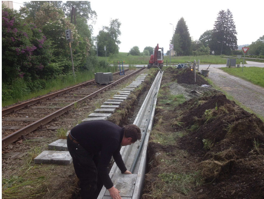
Abbildung 1 + Abbildung 2: Regeleinbaulage LWL-Kabel im Kabeltrochsen
