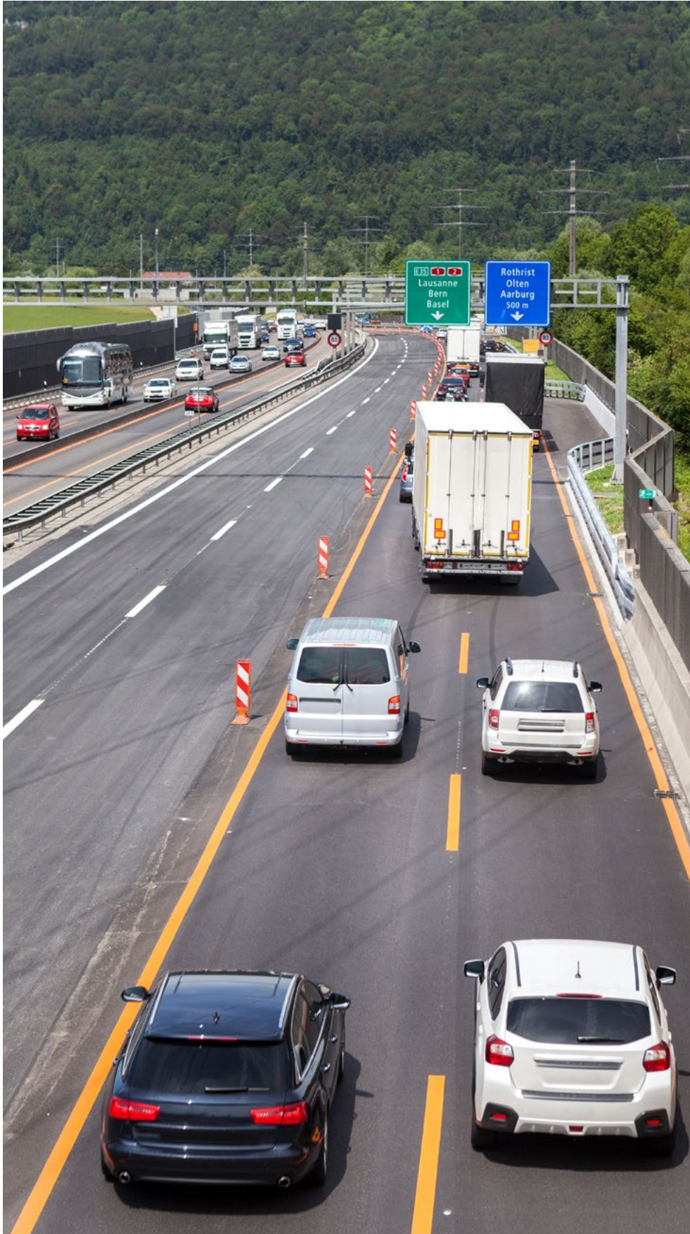
Autobahnbaustelle Schweiz, Quelle: stock.adobe.com
